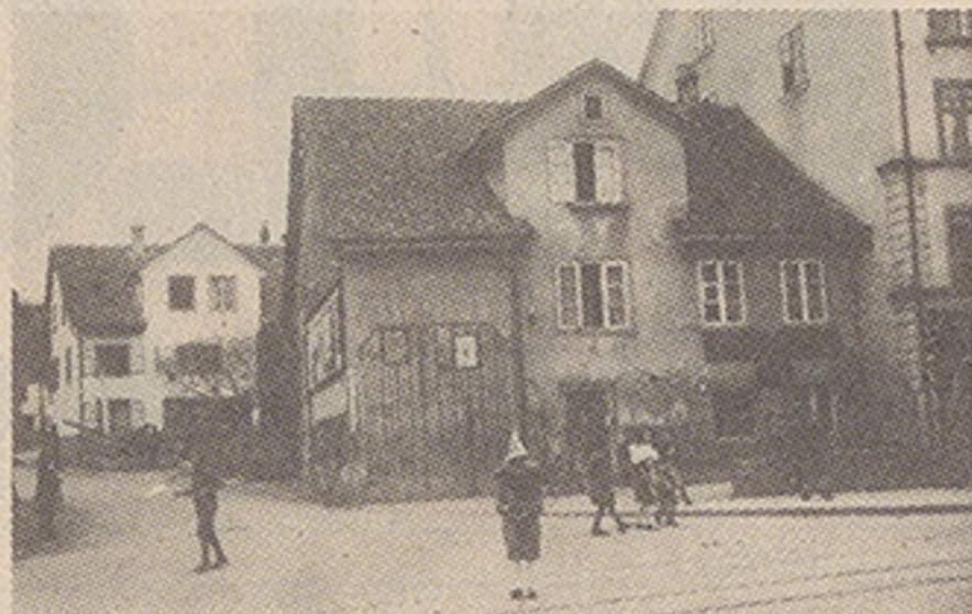
Haus von Churi Notz beim Lindenbrunnen, 1927, kurz vor dem Abbruch
