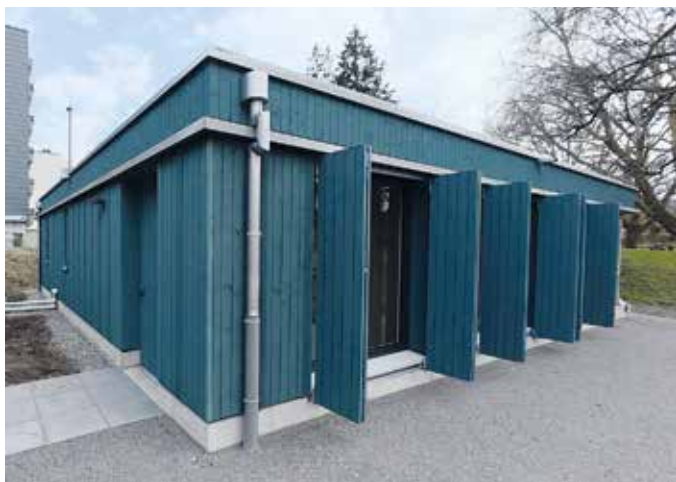
Geheizt wird im Holzbau mit Energie vom Dach und mit einer Wärmepumpe.
