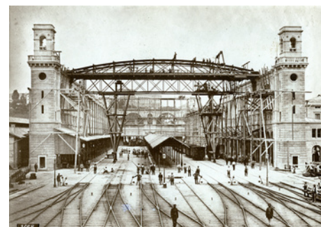
Der neue Hauptbahnhof im Bau, 1867 (Foto: BAZ_098164)
