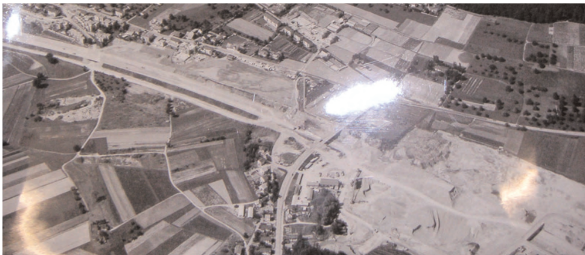
Bau Autobahn A1 Zürich–Bern bei Geroldswil.
