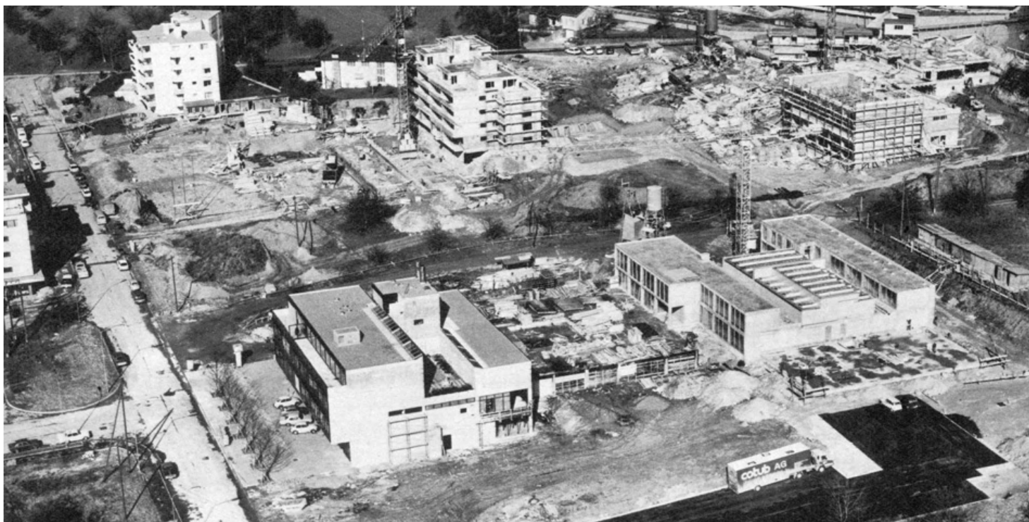
Das Zentrum – eine grosse Baustelle
