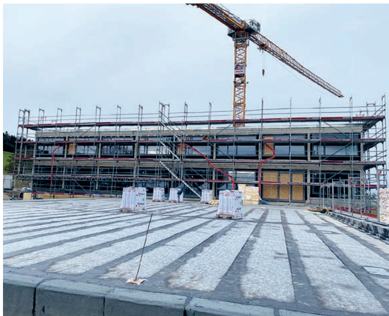
Am Rohbau bereits montiert sind die Fenster.
