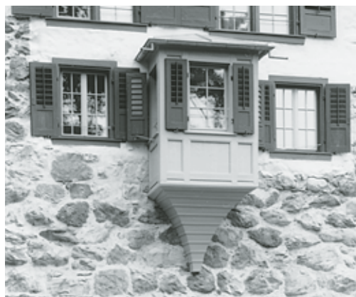
Links und rechts: Kastenerker an der Ostfassade vor und nach der Restaurierung. Zustand November 1997 bzw. März 2000. Fotoarchiv HBA.
