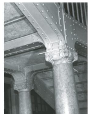
Ausschnitt der Konstruktion des Treppenaufgangs im Lichthof. Zustand Oktober 1994. Fotoarchiv HBA.
