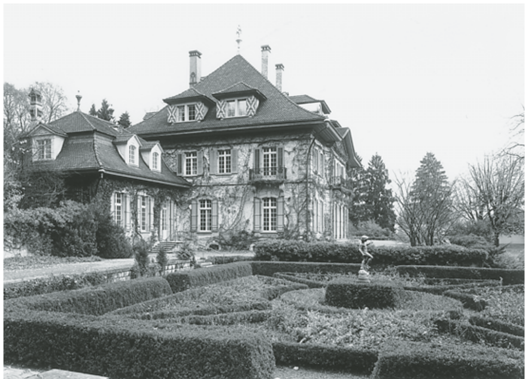
Teilansicht mit Gartenanlage von Südwesten. Zustand nach der Sanierung der Dachwasserinstallationen 1983–1984, November 1989. Fotoarchiv HBA.
