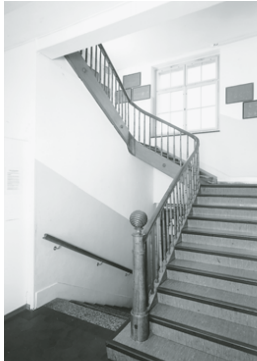
Links: Teilansicht der Südwestfassade mit Eingangspartie nach der Renovation. Zustand September 2002. Rechts: Treppenaufgang ins 1. Obergeschoss nach der Renovation. Zustand September 2002. Fotoarchiv HBA.
