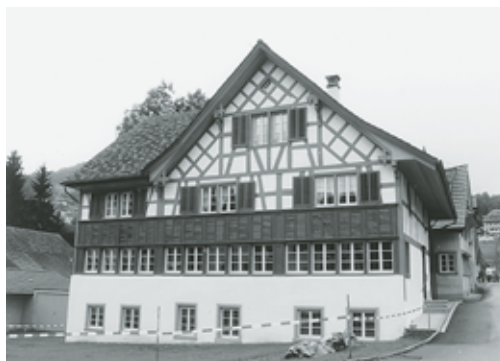
Links: Wald, Altersheim «Tabor», ehem. Fabrikantenvilla «Otto's Ruh» Vers. Nr. 1446, Felsenkeller, Güntisbergstrasse. Nach Dachsanierung 1998.
