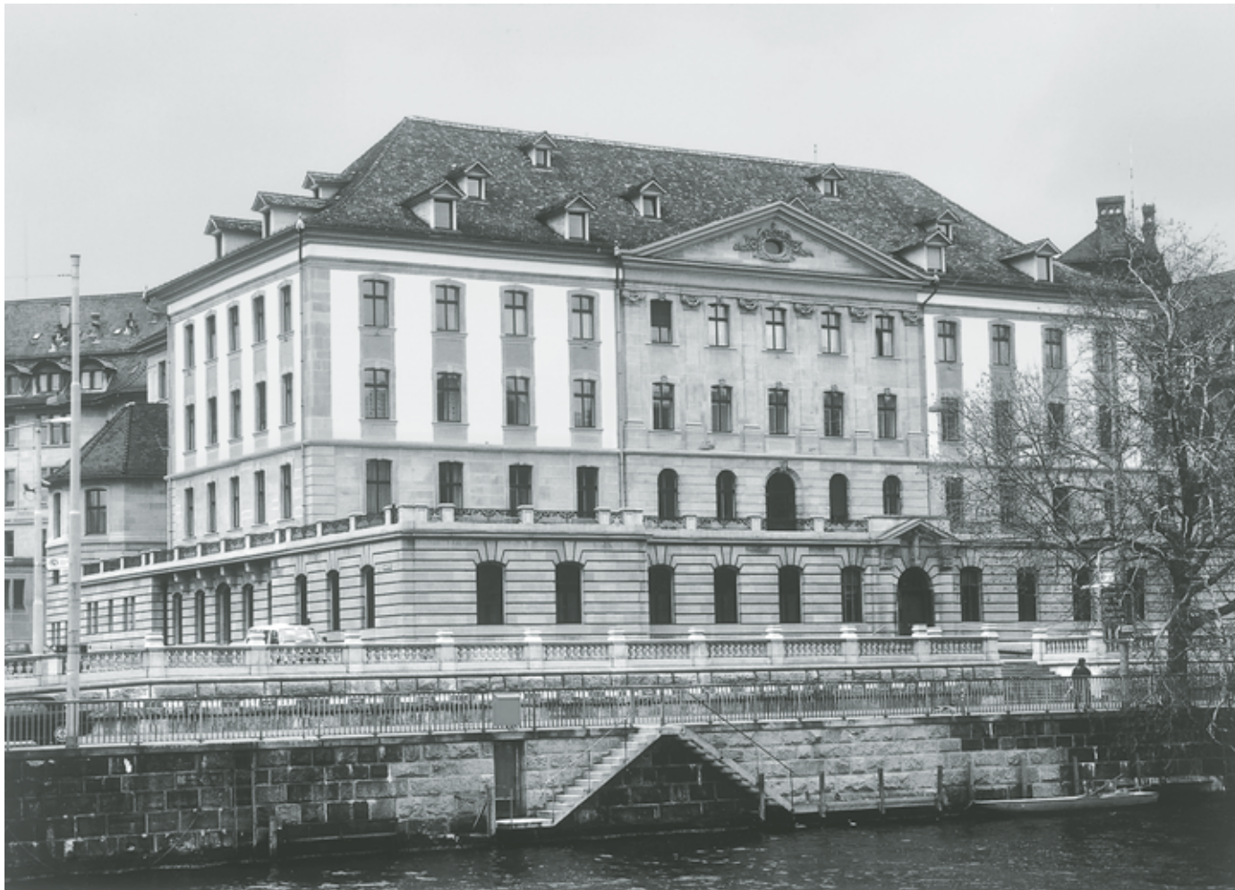
Oben: Gesamtansicht von Südosten nach der Aussenrenovation. Zustand April 2003. Fotoarchiv HBA.
