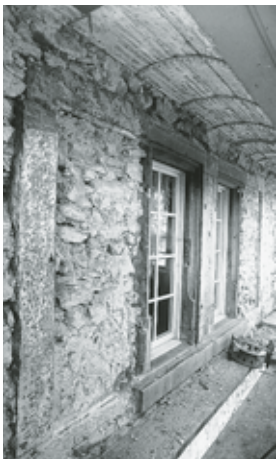
Nordfassade des Turmes im Bereich des Dachansatzes. Nach Entfernen des Verputzes ist das Reihenfenster von 1633 deutlich zu erkennen, das später teilweise vermauert wurde und heute als Doppelfenster erscheint. Zustand während der Aussenrenovation, März 1987. Fotoarchiv HBA.
