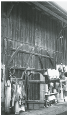
Stallscheune Vers. Nr. 770. Teilansicht der östlichen Trauffassade mit Tenntor vor dessen Ersatz. Zustand September 1993. Fotoarchiv HBA.
