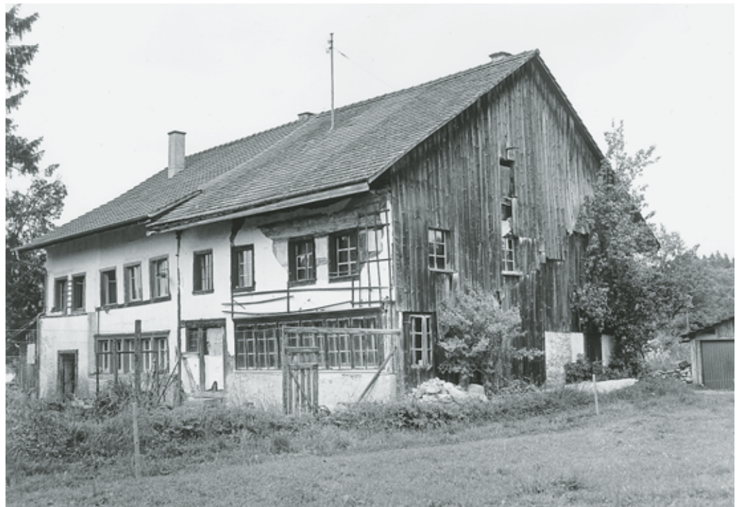
Oben: Gesamtansicht von Südwesten nach Abschluss der Renovation; rechts der Wohnteil Vers. Nr. 654 mit dem über 500jährigen Ständergerüst und der nachträglichen Fachwerkfassade; ganz links der neu errichtete Wohnteil. Zustand Frühjahr 1999. Unten: Gesamtansicht von Südwesten. Zustand Mai 1972. Fotoarchiv HBA.
