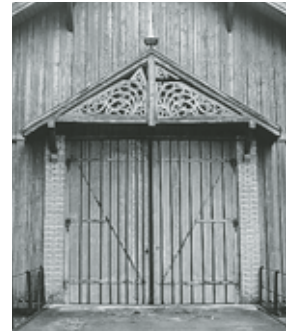
Hocheinfahrt von Osten beim Stallgebäude I (Vers. Nr. 110). Zustand 1974. Fotoarchiv HBA.
