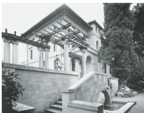
Links: Hofeinfahrt mit der Ost- und Nordfassade. Zustand nach der Gesamtrestaurierung, Mai 2002. Fotoarchiv HBA. Rechts: Gartenbereich im Westen mit dem restaurierten Brunnen und dem Treppenaufgang zur Pergola. Zustand Oktober 2001. Fotoarchiv HBA.
