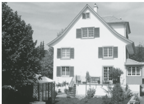
Links: Stäfa, ehem. Bauernhaus Vers. Nr. 103, Uerikon, Gsteig, Ritterhausstrasse 51. Nach Fenstersanierung und Umsetzen des Kachelofens 1997–1998.
