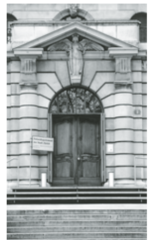
Übergiebelter Haupteingang am eingeschossigen Vorbau nach der Aussenrenovation. Zustand April 2003. Fotoarchiv HBA.
