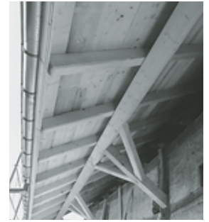
Neues, strebengestütztes Vordach auf der östlichen Traufseite. Zustand Juli 1997. Fotoarchiv HBA.
