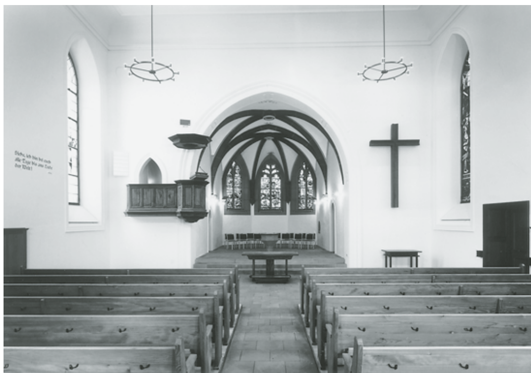
Gesamtaufnahme gegen den Chor nach der Renovation. Dabei wurden im Polygonalchor u.a. die spätgotischen Gewölberippen samt den Konsolsteinen freigelegt und deren Fassung (Caput mortuum) samt den grauen Begleitlinien restauriert bzw. ergänzt. Zustand Dezember 1998. Fotoarchiv HBA.
