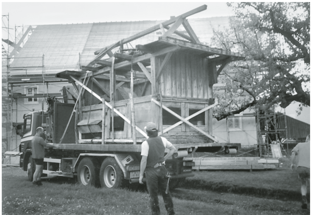
Oben: Gesamtansicht des um wenige Meter verschoben und renovierten Schweinestalls von Südosten. Zustand September 2001. Fotoarchiv HBA. Rechts: Abtransport des renovationsbedürftigen Kleingebäudes in die Zimmereiwerkstatt im August 2000. Fremdaufnahme im ZDA (Objektdossier).
