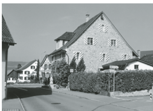
Links und rechts: Uster, Gasthof «Krone» Vers. Nr. 1440, Nossikon, Burgstrasse 81. Nach Aussenrenovation 1998. Links Wirtshausschild.
