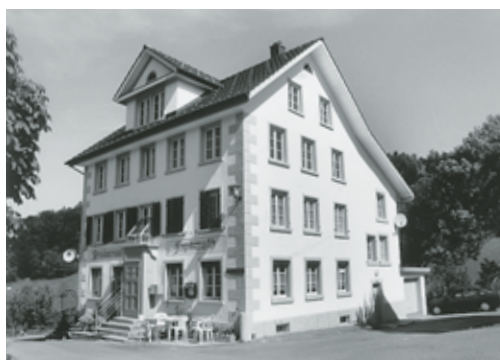
Links: Wädenswil, Wohnhaus, ehem. Doppelbauernwohnhaus Vers. Nrn. 1431, 1432, Stocken, Stockenweg. Foto 2003.
