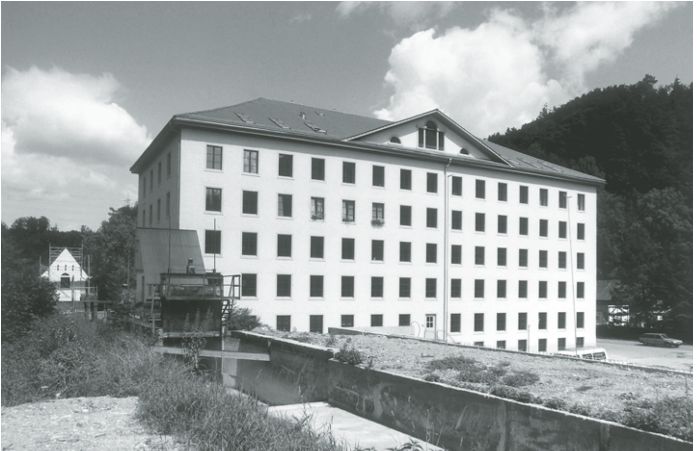
Oben: Gesamtansicht des ehemaligen Spinnerei-Hauptbaus von Südosten nach der Renovation. Dabei wurde der für die Kunz'schen Spinnereien charakteristische Quergiebel mit Palladiomotiv rekonstruiert. Zustand Juli 1998. Fotoarchiv HBA. Rechts: Historische Ansicht des Fabrikkomplexes von Nordwesten mit dem Hauptbau, dem Flachbau mit Sheddach und dem markanten Hochkamin. Zustand 1903–1913. Fotoabzug aus Privatbesitz im ZDA.
