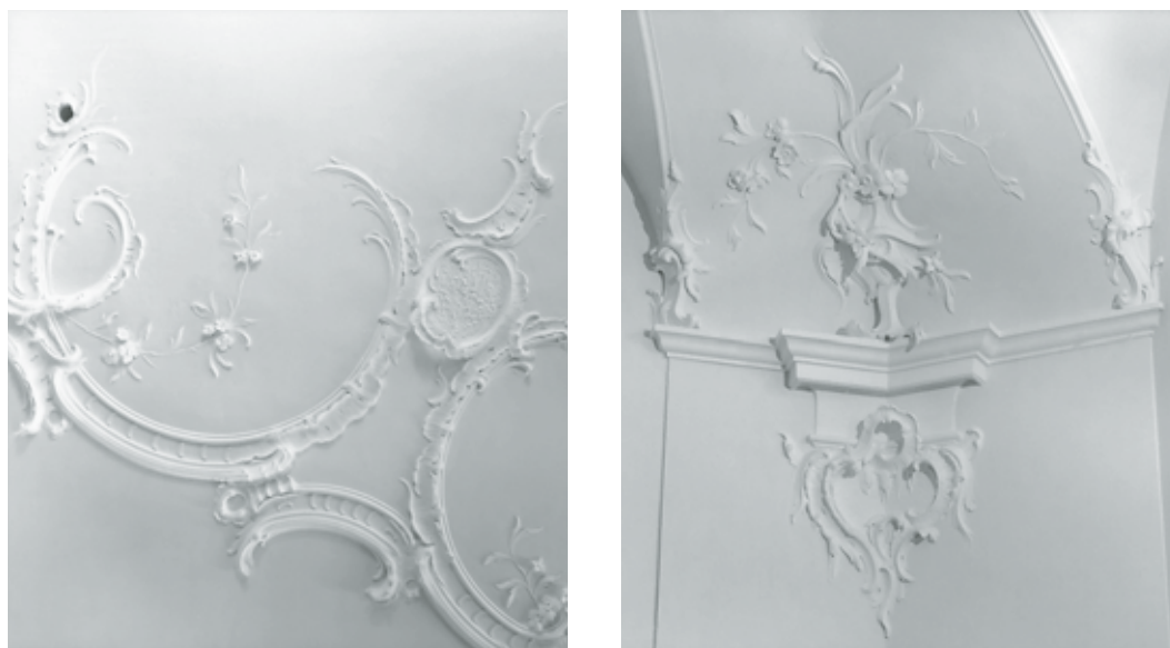
Links und rechts: Stuckdetails nach der Restaurierung. Zustand Juli 1999. Fotoarchiv HBA.
