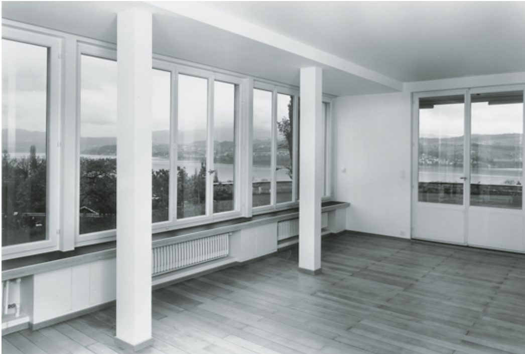
Wohnraum im Erdgeschoss mit abgeänderten Stützen und wiederhergestellter Fensterteilung. Zustand April 2000. Fotoarchiv HBA.
