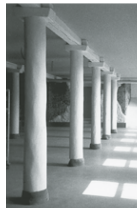
Teilansicht eines ehemaligen Fabriksaals vor Abschluss der Renovation 1998. Fotoarchiv HBA.
