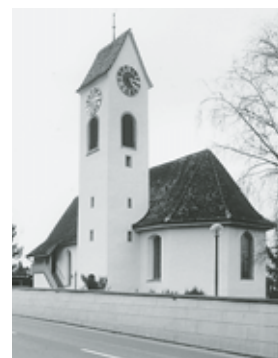
Gesamtansicht mit Einfriedungsmauer von Südosten. Zustand nach der Aussenrenovation 2000. Fotoarchiv HBA.
