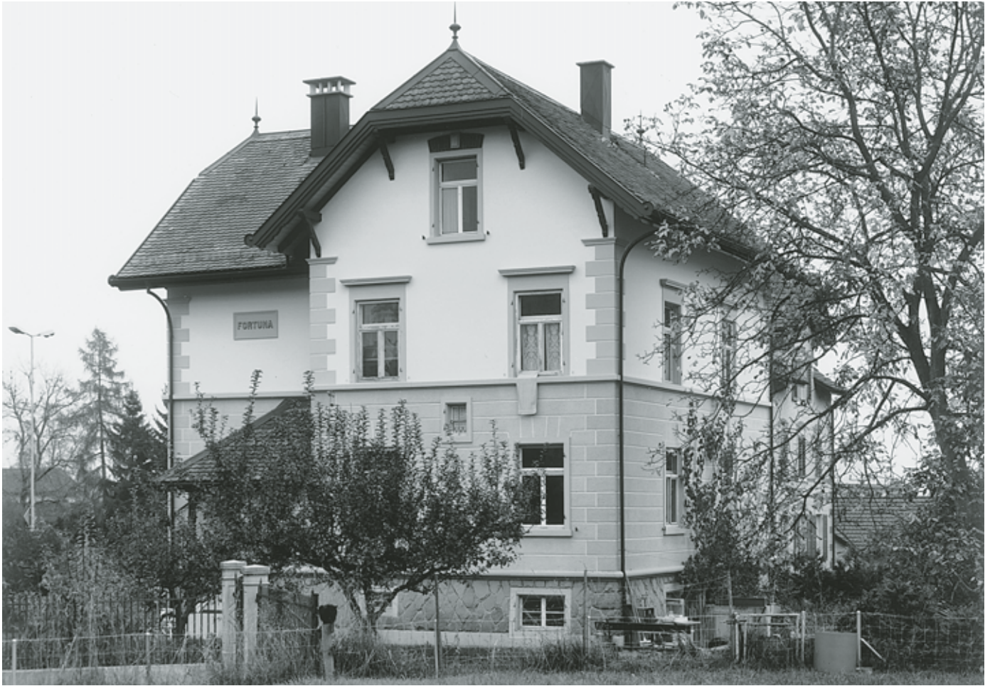
Oben: Gesamtansicht von Nordwesten. Die Anstriche der Fassaden (Neapelgelb, Grau und Ziegelrot) sowie der Fenster und Fensterläden (dunkles Grünblau) wurden nach Befund erneuert. Die Eisenteile, Steinelemente, das Holzwerk und das Dach wurden instandgestellt. Zustand nach der Aussenrenovation, November 1995. Rechts: Zimmer im Obergeschoss mit restaurierter Schablonenmalerei. Zustand Juli 1997. Fotoarchiv HBA.
