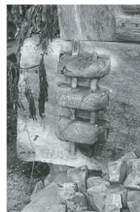
Teilansicht der mächtigen Eichenschwelle mit dreifachem Schwellenschloss an der östlichen Gebäudeecke. Zustand 1995. Fotoarchiv HBA.
