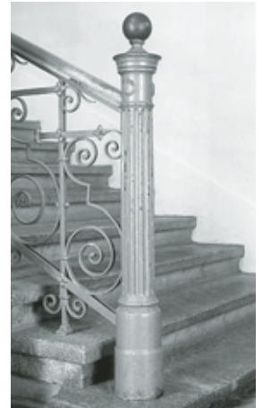
Antrittsposten der Haupttreppe im Oberen Bau des Hauptgebäudes. Zustand Dezember 1992. Fotoarchiv HBA.
