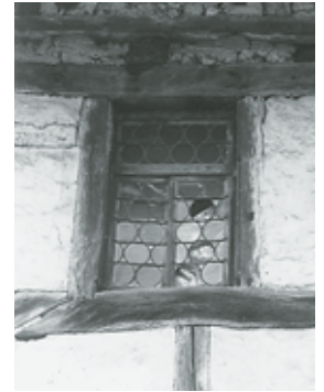
Altes Butzenfenster am Obergeschoss der Westfassade. Zustand 1990. Fotoarchiv HBA.
