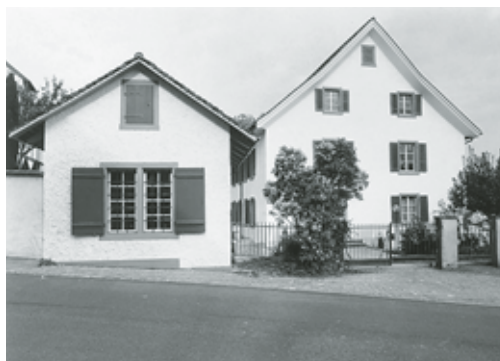
Links: Berg a.I., Schloss Vers. Nr. 52, Schlossgasse 10. Nach Fenster-sanierung 1997–1998.
