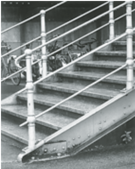
Detail der im Frühjahr 2000 abgebrochenen Passerelle über die Bahngeleise. Antritt der einläufigen Treppe unmittelbar nordöstlich des Güterschuppens, Zustand 1997. Fotoarchiv HBA.
