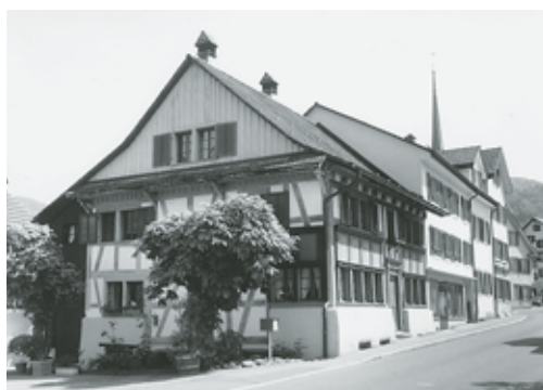
Links: Wald, Ökonomiegebäude der ehemaligen Brauerei «Zum Schwert» (links und hinten), Vers. Nrn. 1565–1568, Tösstalstrasse. Abbruch im Jahr 2000.
