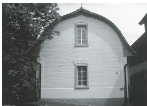
Stäfa, sog. Hädelihäuser: Wohnhaus, ehem. Gewerbehäuser für die Seidenindustrie Vers. Nrn. 1058, 245 (links) und Ateliergebäude, ehem. Ökonomiegebäude Vers. Nr. 1061 (rechts), Oberhausenstrasse 24, Zihlweg 2. Nach Gesamtrenovation 1995–2000.
