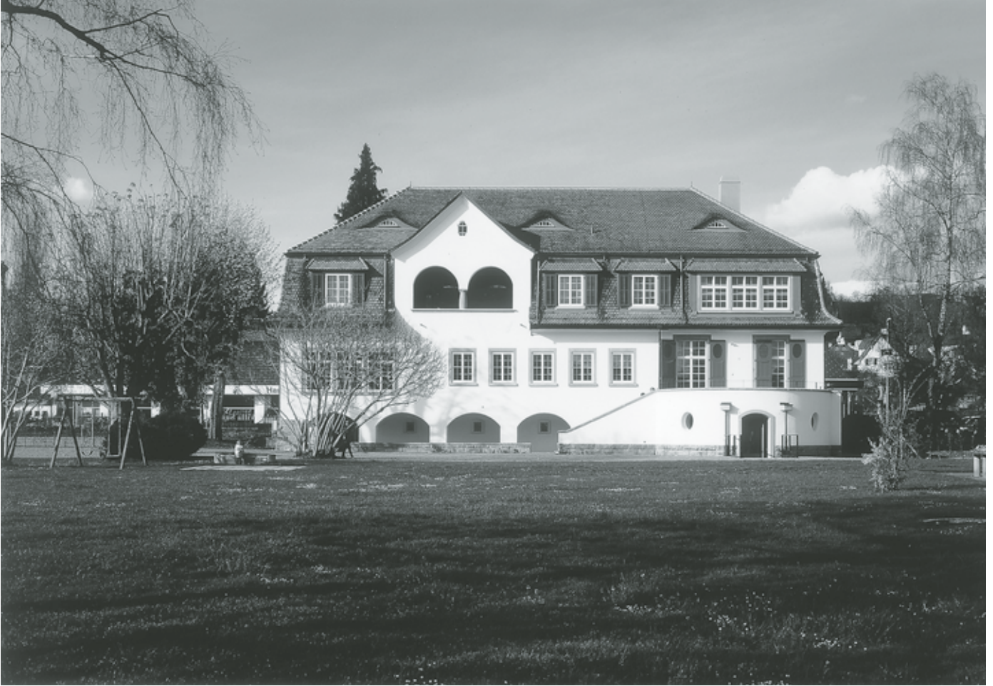
Oben: Gesamtansicht von Südwesten nach der Gesamtrenovation. Die Loggien am Kellergeschoss sowie am Quergiebel wurden wieder hergestellt. Zustand März 2001. Rechts: Die Südwestfassade mit den deutlich erkennbaren, nachträglichen Veränderungen. Zustand Oktober 1970. Fotoarchiv HBA.
