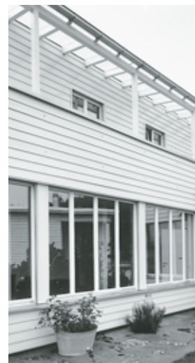
Teilsicht der Ostfassade nach der Renovation. Wiederhergestellt sind die Fensterteilung im Erdgeschoss und das Glasoblicht am Laubengang. Zustand Juni 2000. Fotoarchiv HBA.
