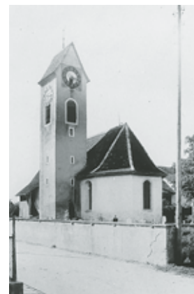
Gesamtansicht mit Friedhofsmauer von Südosten. Zustand 1. Viertel 20. Jahrhundert. ZBZ, graph. Slg.
