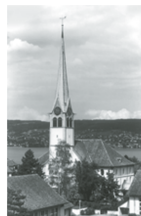
Gesamtansicht von Süden. Zustand nach der Aussenrenovation, August 1986. Fotoarchiv HBA.
