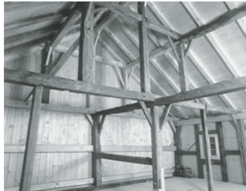
Links: Stube im Erdgeschoss nach der Restaurierung. Zustand Dezember 1997. Rechts: Blick in die Scheune mit dem stehenden Dachstuhl von 1625 nach der Restaurierung. Zustand Dezember 1997. Fotoarchiv HBA.
