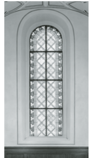
Chorscheitelfenster mit floral und ornamental verzierter Bleiverglasung. Zustand nach der Renovation, April 1999. Fotoarchiv HBA.
