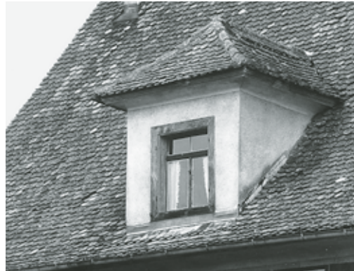
Links: Keller- und Schopfgebäude Vers. Nr. 883. Eingangspartie mit Rundbogentüre und seitlich angeordneten, vergitterten Fenstern. Zustand September 1996. Rechts: Teilansicht der südöstlichen Dachfläche mit alter Ziegeleindeckung und Walmdachlukarne. Zustand vor der Renovation, September 1996. Fotoarchiv HBA.
