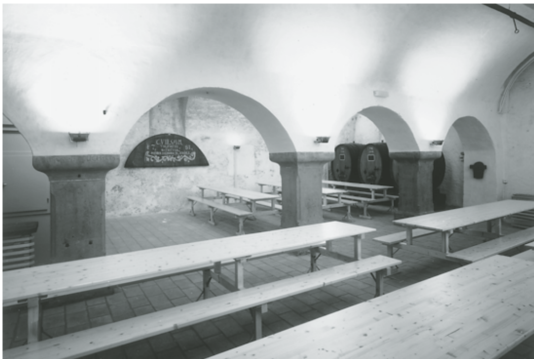
Der zweischiffige Rathauskeller mit Stützenreihe und Tonnengewölbe nach Ausbau und Renovation 2000. Fotoarchiv HBA.
