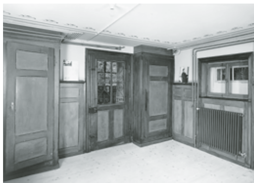
Links: Wädenswil, Wohnhaus «Zur Schiffhütte» Vers. Nr. 648, Seestrasse 150. Vor Gesamtrenovation 1997.
