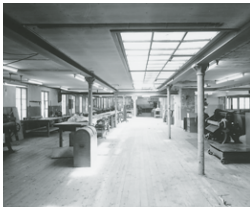
Links: Fabrikationsgebäude Vers. Nr. 739 (vorher Nr. 738). Inneres der Riemerei im 1. Obergeschoss mit Rundstützen und Glasoblicht. Rechts: Kessel- und Maschinenhaus Vers. Nr. 739 (vorher Nr. 741). Frontalansicht des Zweiflammenrohrkessels Nr. 2 der Dampfkesselanlage der Gebr. Sulzer. Winterthur, von 1916. Zustand Juni 1999. Fotoarchiv HBA.
