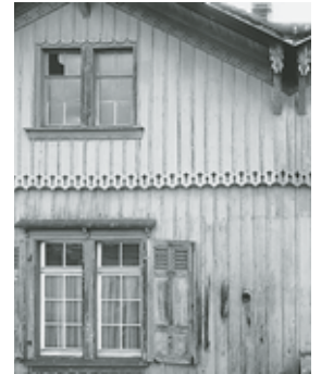
Teilansicht der nordöstlichen Giebelfassade mit dekorativer vertikaler Holzschalung in Formen des Schweizer Holzstils. Zustand Januar 2000. Fotoarchiv HBA.
