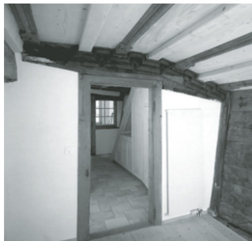
Links: Ehemalige Trinkstube im Obergeschoss nach der Restaurierung. Zustand September 1997. Fotoarchiv HBA.
