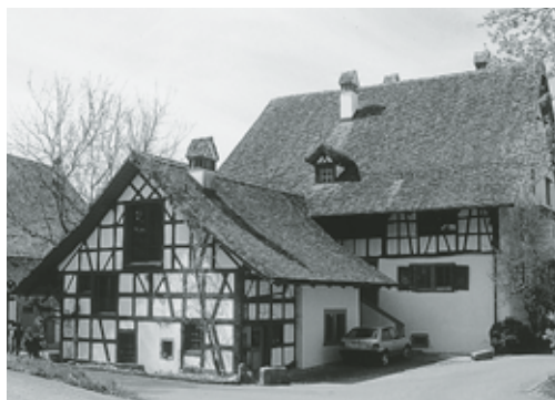
Hombrechtikon, Bauernwohnhaus, sog. Hürlimannhaus mit Remise Vers. Nrn. 832, 834, Lützelsee 2, 4. Links Wohnhaus nach der Dachsanierung, rechts die renovierte Remise. Fotos 2003.
