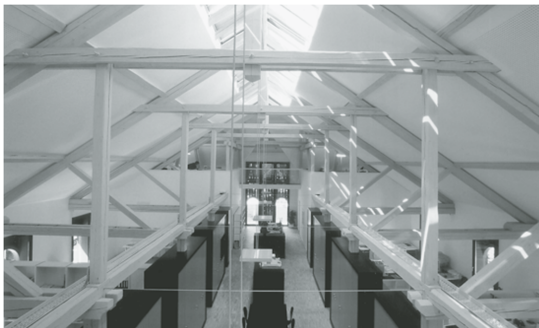
Inneres des ehemaligen Ökonomiegebäudes. Grossraumbüro von der Nordostgalerie her gesehen. Deutlich erkennbar sind die ursprüngliche Holzständerkonstruktion und der neu geschaffene, verglaste Dachreiter zur besseren Belichtung. Zustand nach der Renovation und Umnutzung, Juli 2002. Fotoarchiv HBA.
