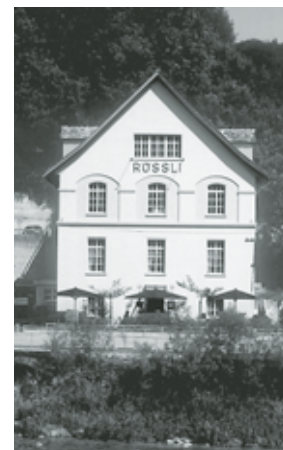
Westfassade des zum Restaurant «Rössli» umgenutzten ehemaligen Magazingebäudes Vers. Nr. 470. Zustand nach der Renovation, August 1995. Fotoarchiv HBA.
