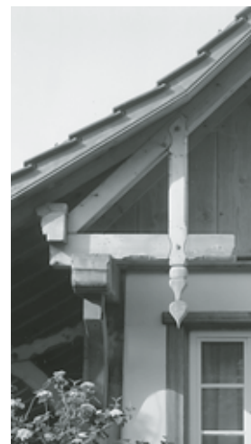
Wiederhergestellte Flugsparrenkonstruktion an der Ostfassade. Zustand Mai 2003. Fotoarchiv HBA.
