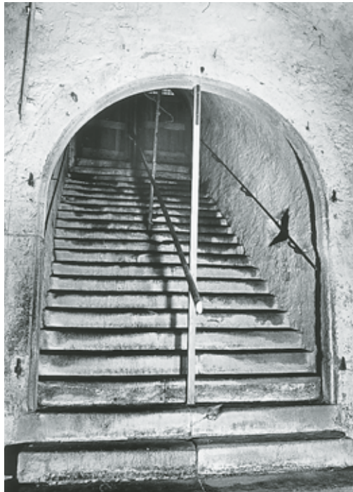
Tonnengewölbter Abgang von Aussen in den Rathauskeller. Zustand 1975 (links) und 2000 (rechts). Fotoarchiv HBA.
