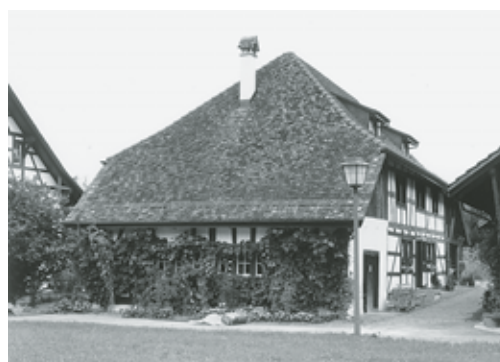
Links: Fischenthal, Bauernhaus Vers. Nr. 448, Breitenmatt. Nach Fenster-sanierung 1997.
