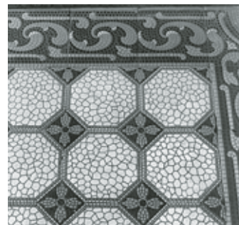
Details im Oberen Bau des Hauptgebäudes. Links: Schmiedeeisernes Treppengeländer. Mitte: Türdrücker in Form einer Löwin (?) mit Fischschwanz. Rechts: Boden aus Steinzeugplatten mit Mosaikimitation. Zustand Dezember 1992. Fotoarchiv HBA.
