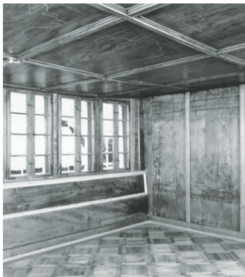
Links: Tonnengewölbter Kellerraum mit Bollensteinpflasterung unter dem Wohnteil. Zustand Dezember 1998. Rechts: Blick in die Wohnstube mit gekoppelten Fenstern. Wand und Decke mit Bretter- und Feldertäferverkleidungen, die Reste von Malereien aufweisen. Zustand nach der Renovation, Dezember 1998. Fotoarchiv HBA.
