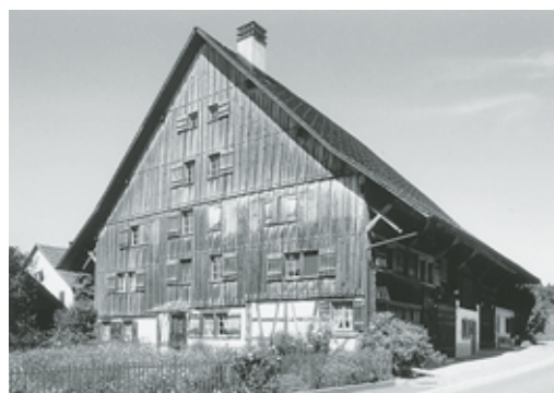
Links: Hütten, Doppelbauernhaus Vers. Nrn. 78, 135, Unter Oerischwand. Nach Fassadenrenovation 1996.
