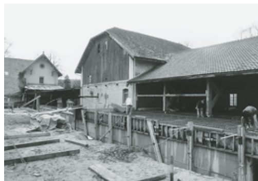
Reithalle und Wagenschopf (Vers. Nr. 112). Links: Westfassade. Zustand 1974. Rechts: Teilansicht von Osten während der Umbauarbeiten 1996; links im Hintergrund ist das Stallgebäude I sichtbar. Fotoarchiv HBA.
