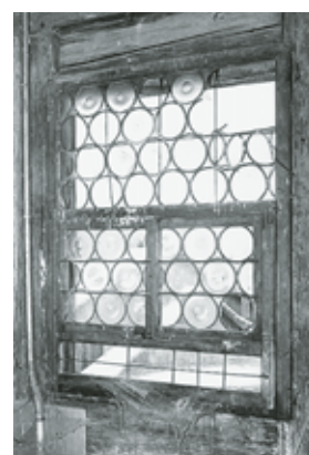
Fenster mit alter, bleigefasster Butzenscheibverglasung im 2. Dachgeschoss. Zustand Februar 1992. Fotoarchiv HBA.
