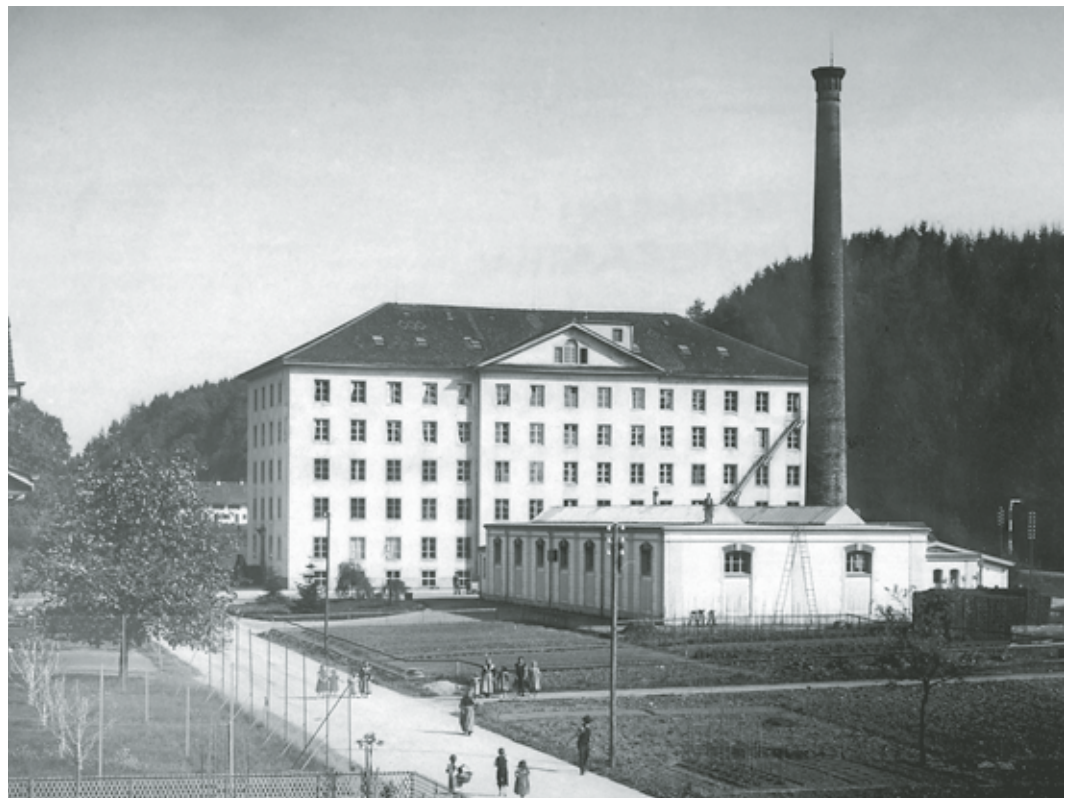
Oben: Gesamtansicht des ehemaligen Spinnerei-Hauptbaus von Südosten nach der Renovation. Dabei wurde der für die Kunz'schen Spinnereien charakteristische Quergiebel mit Palladiomotiv rekonstruiert. Zustand Juli 1998. Fotoarchiv HBA. Rechts: Historische Ansicht des Fabrikkomplexes von Nordwesten mit dem Hauptbau, dem Flachbau mit Sheddach und dem markanten Hochkamin. Zustand 1903–1913. Fotoabzug aus Privatbesitz im ZDA.
