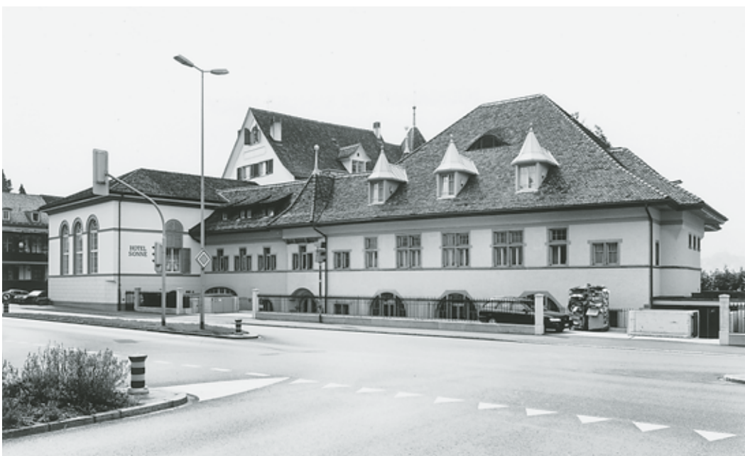
Gesamtansicht von Nordosten. Links der Saalbau I von 1839 mit den drei Rundbogenfenstern, rechts der Saalbau II von 1911–1912 mit den drei neu geschaffenen Lukarnen; im Hintergrund ist der Altbau aus dem 17./18. Jahrhundert erkennbar. Zustand nach der Aussenrenovation 1987 bzw. dem Innenumbau 1996–1998, September 1998. Fotoarchiv HBA.
