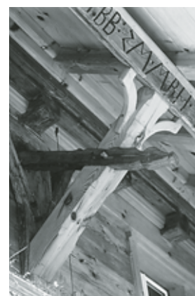
Reparierte bzw. ergänzte Vordachkonstruktion an der Südfassade mit Ausschnitt der Flugpfetteninschrift. Zustand Mai 2003. Fotoarchiv HBA.
