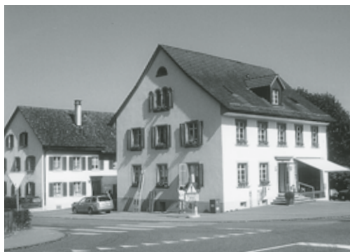
Links: Andelfingen, Wohnhaus «Unterer Felsenhof» Vers. Nr. 120, Felsenhofstrasse 8. Nach Dach- und Fassadenrenovation 1999.
