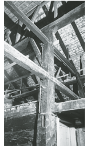
Rauchgeschwärmte Hochstudkonstruktion aus der Bauzeit. Zustand 1972. Fotoarchiv HBA.
