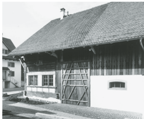
Nordöstliche Trauffassade mit Wohnteil, Tenne und Stall vor bzw. nach der Gesamtrenovation 1996– 1997. Zustand 1995 bzw. 1997. Fotoarchiv HBA.
