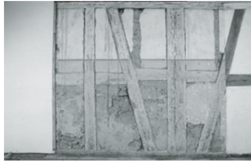
Links: Kranzkacheln des grossen Ofens in der westlichen Stube im Erdgeschoss. Zustand 1997. Rechts: Freigelegte Fachwerktrennwand im Korridor des Erdgeschosses mit Spuren einer Graufassung und einem ockerfarbenen Anstrich. Zustand Januar 1999, vor der Renovation. Fotoarchiv HBA.
