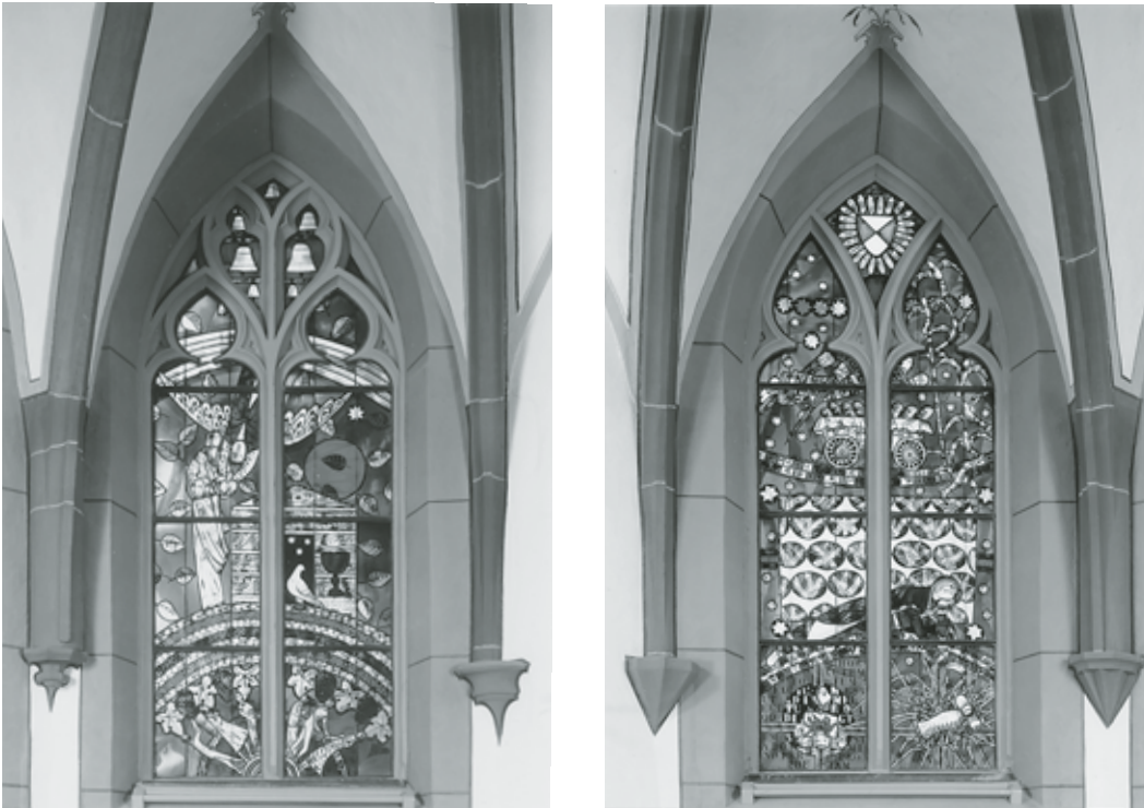
Linkes Chorfenster (links) bzw. Chorscheitelfenster (rechts) mit Masswerken und figürlichen Farbscheiben von Glasmaler Max Hunziker (1901–1976), Zürich. Dargestellt sind links die Themen Werden (Taufe) und rechts Sein (Hochzeit). Zustand nach der Restaurierung des Innern 1998 mit den in Caput mortuum gefassten Gewölberippen und den grauen Fenstereinfassungen mit hellen bzw. dunklen Fugenstrichen. Zustand Dezember 1998. Fotoarchiv HBA.
