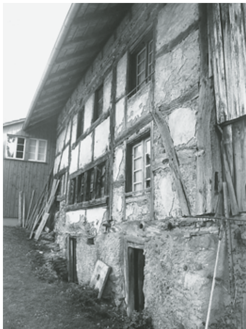
Oben: Gesamtansicht von Südosten vor Beginn der Renovationsarbeiten. Zustand Frühjahr 1997. Unten: Westliche Trauffassade aus der Mitte des 16. Jahrhunderts mit bedeutenden Bauschäden bzw. in restauriertem Zustand. Aufnahmen 1997 bzw. Februar 1999. Fotoarchiv HBA.
