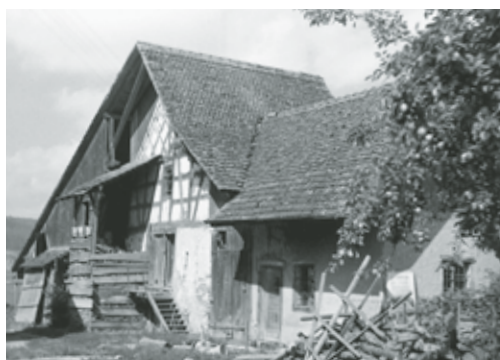
Links: Regensdorf, Speicher Vers. Nr. 147, Watt, Unterdorfstrasse. Nach Renovation 1999–2000.
