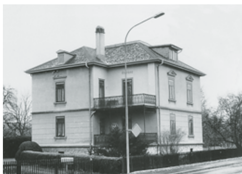
Links: Weiningen, Wohnhaus mit ehem. Wagnerei und Sägerei Vers. Nr. 65, Zürcherstrasse 15. Vor Abbruch 1998.
