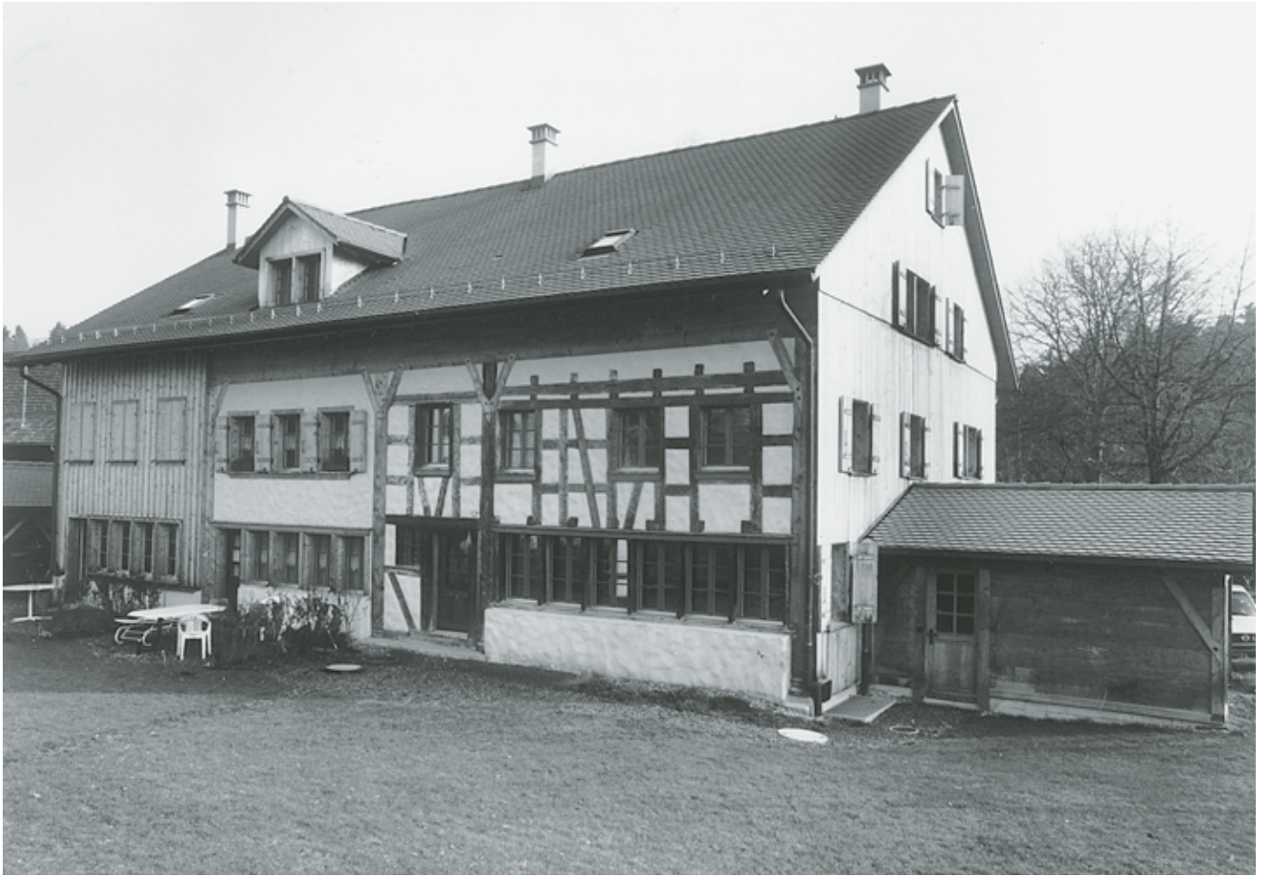
Oben: Gesamtansicht von Südwesten nach Abschluss der Renovation; rechts der Wohnteil Vers. Nr. 654 mit dem über 500jährigen Ständergerüst und der nachträglichen Fachwerkfassade; ganz links der neu errichtete Wohnteil. Zustand Frühjahr 1999. Unten: Gesamtansicht von Südwesten. Zustand Mai 1972. Fotoarchiv HBA.
