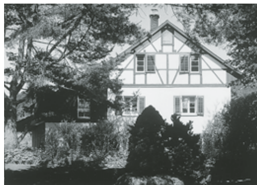
Links: Laufen-Uhwiesen, ehem. Weinbauernhaus Vers. Nr. 56, Uhwiesen, Kirchgasse 10. Nach Aussenrenovation und Innenumbau 1998–1999.
