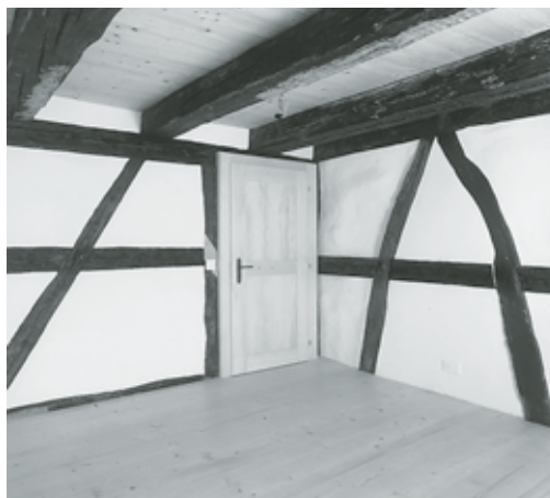
Links: Ansicht der Stube des nördlichen Wohnteils mit rekonstruierter Bohlenbalkendecke und schabloniertem Kachelofen mit Sitzkunst aus dem 19. Jahrhundert. Zustand nach der Renovation, März 1998. Rechts: Kammer im Obergeschoss des südlichen Wohnteils. Zustand nach der Renovation, März 1998. Fotoarchiv HBA.
