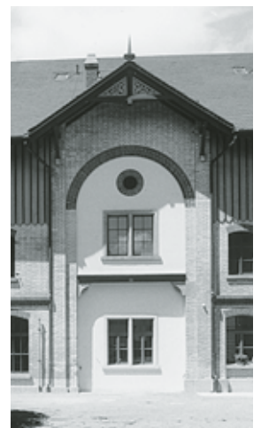
Teilansicht der Südostfassade des ehem. Stallgebäudes II, heute Clubhaus. Der Quergiebelausbau markiert die ehemalige Durchfahrt. Zustand 2000. Fotoarchiv HBA.
