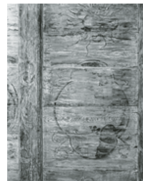
Ausschnitt der restaurierten, mit Blumenornamenten in Grisaille bemalten Balkendecke im Raum Nr. 1.06. Zustand Oktober 1998. Fotoarchiv HBA.
