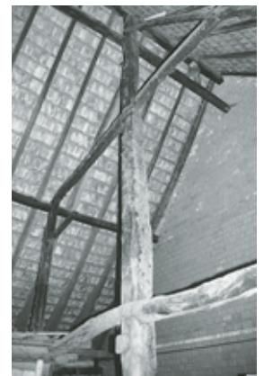
Hochstud im ehemaligen Ökonomieteil. Rechts die Brandmauer zum Nachbargebäude Vers. Nr. 9 (Ersatzbau von 1984–1985). Zustand 1997. Fotoarchiv HBA.
