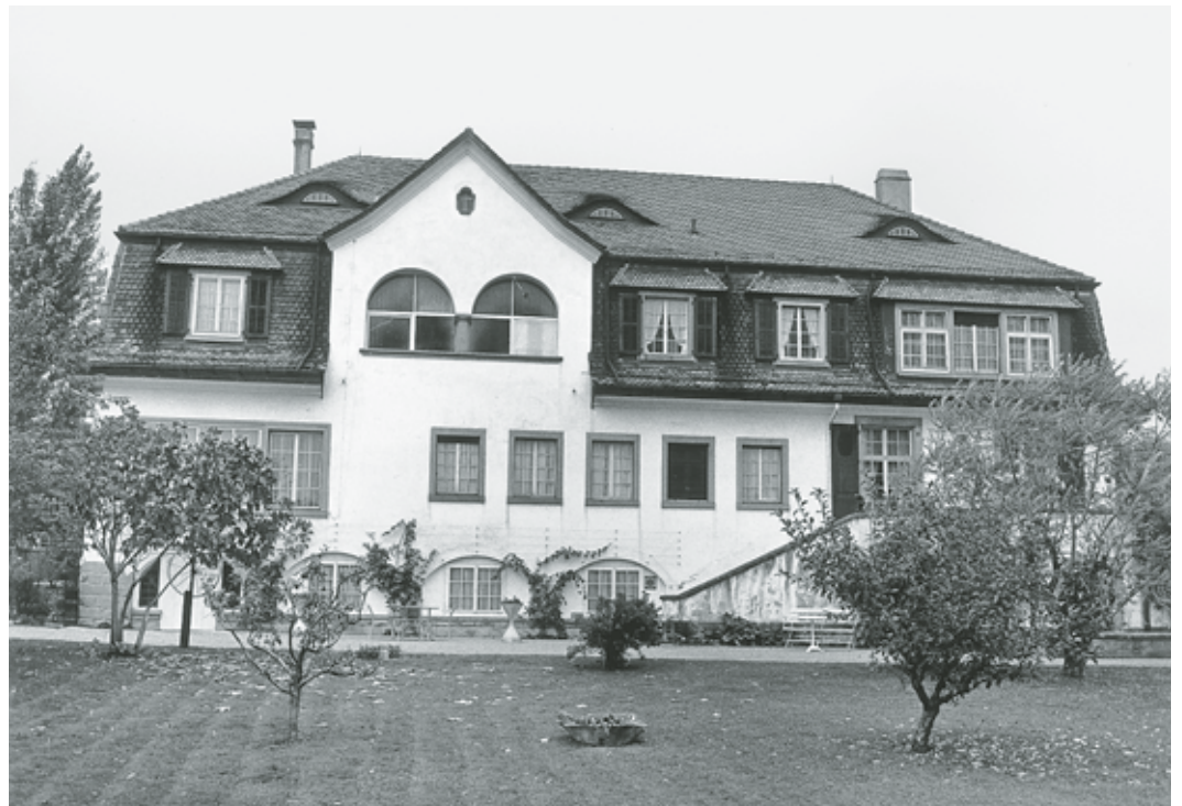
Oben: Gesamtansicht von Südwesten nach der Gesamtrenovation. Die Loggien am Kellergeschoss sowie am Quergiebel wurden wieder hergestellt. Zustand März 2001. Rechts: Die Südwestfassade mit den deutlich erkennbaren, nachträglichen Veränderungen. Zustand Oktober 1970. Fotoarchiv HBA.
