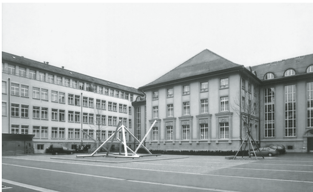
Innenhof des Bezirksgebäudes mit Blick gegen den vorspringenden Gerichtssaalflügel unter Walmdach. Im Vordergrund die neu geschaffene Skulptur «Angulon» von Plastiker Florin Granwehr (*1942), Zürich. Zustand nach der Renovation, April 2000. Fotoarchiv HBA.
