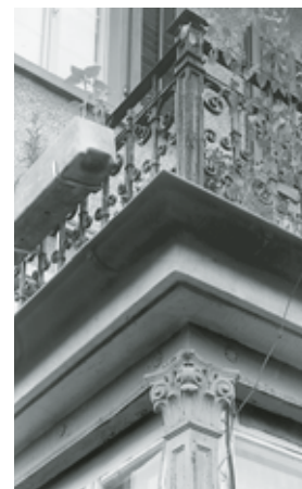
Eckausschnitt der Veranda von 1901 an der Ostseite der Villa. Zustand vor dem Abbruch, Juni 1999. Fotoarchiv HBA.
