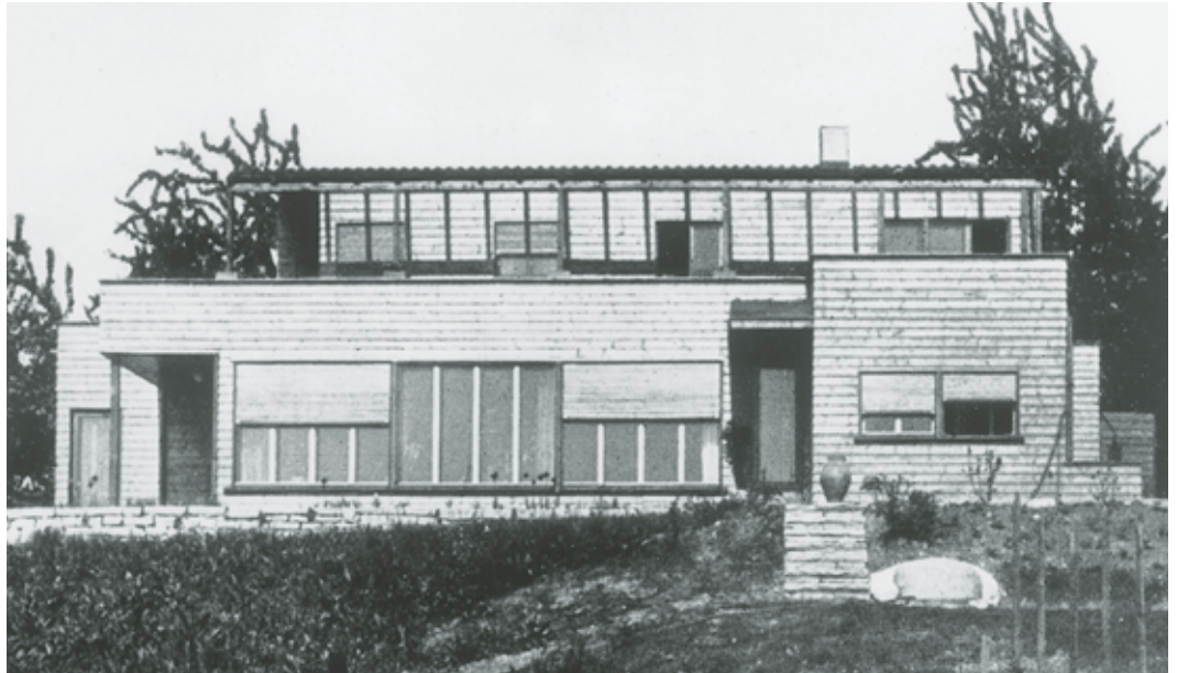
Ansicht von Osten (Gartenansicht). Zustand nach Bauvollendung 1933. Repro aus Dok. 2. Fotoarchiv HBA.
