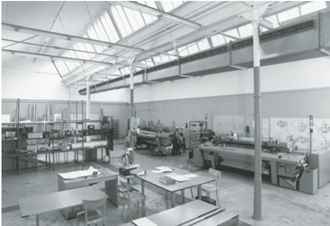
Oben links: Teilansicht der Fabrikhalle im Erdgeschoss des Unteren Baues des Hauptgebäudes vor der Renovation bzw. Umnutzung. Zustand Dezember 1992. Fotoarchiv HBA. Oben rechts: Die ehemalige Fabrikhalle nach der Renovation und Umnutzung. Im jetzigen Büroraum blieben die Gusseisenstützen, Stahlunterzüge und Zugstangen sichtbar. Zustand Februar 2002. Fotoarchiv HBA.
