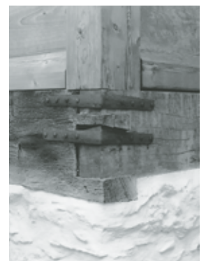
Eckverzinkung der Eichen-schwellen an der Süd-ostecke. Zustand nach der Restaurierung bzw. Wiederherstellung, Juni 1999. Fotoarchiv HBA.
