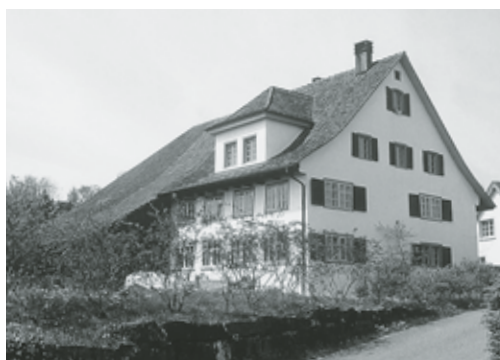
Links: Dürnten, Schulhaus «Tannenbühl» Vers. Nr. 790, Tann, Schulstrasse 5. Nach Renovation 1996–1997.
