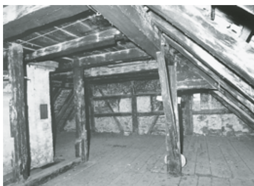
Links: Dachraum über dem südlichen Wohnteil, Blick auf die Fachwerk-Trennwand zum Scheunenteil. Rechts: Dachraum über dem südlichen Wohnteil, Blick auf die Trennwand zum nördlichen Wohnteil. Zustand vor der Renovation, Oktober 1987. Aufnahmen BHF, Fotoarchiv HBA.
