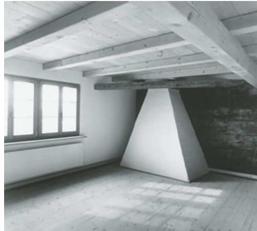
Hausteil Vers. Nr. 654. Links: Teilansicht der getäfernten Stube im Erdgeschoss mit neu aufgesetztem Kachelofen des 17. Jahrhunderts. Er stammt aus dem Lagerbestand der kantonalen Denkmalpflege. Rechts: Kammer im Obergeschoss mit gemauertem Rauchfang nach der Renovation. Zustand März 1999. Fotoarchiv HBA.
