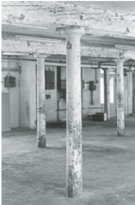
Teilansicht des ehemaligen FabrikSaals im 3. Obergeschoss mit den originalen Rundstützen aus der Bauzeit. Zustand Januar 1984. Fotoarchiv HBA.
