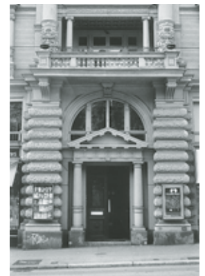
Eingangspartie mit übergiebeltem Portal. Zustand August 1996. Fotoarchiv HBA.
