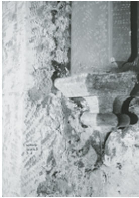
Konsolstein und Rippenansatz im Polygonalchor mit begleitender Grisaillemalerei. Zustand nach der Freilegung 1998. Dok. 15.
