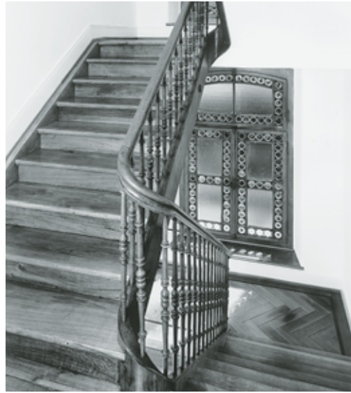
Links: Korridor im 2. Obergeschoss mit Blick gegen die Abschlusstüre zum Treppenhaus; am linken Bildrand der Aufgang zum Dachgeschoss. Rechts: Treppenhaus im Bereich des 1. Obergeschosses. Zustand nach der Renovation, Oktober 2000. Fotoarchiv HBA.
