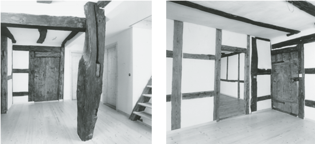
Links: Vorplatz im Obergeschoss mit zentralem Hochstud aus Eichenholz. Rechts: Kammer im Obergeschoss, rechts im Bild Bretttertüre mit Einschubleisten zum Vorplatz. Zustand nach der Gesamtrestaurierung 1997–1998. Fotoarchiv HBA.
