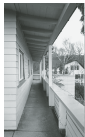
Laubengang am Obergeschoss vor der Renovation mit nachträglich verlängerter Eindeckung. Zustand März 1998. Fotoarchiv HBA.
