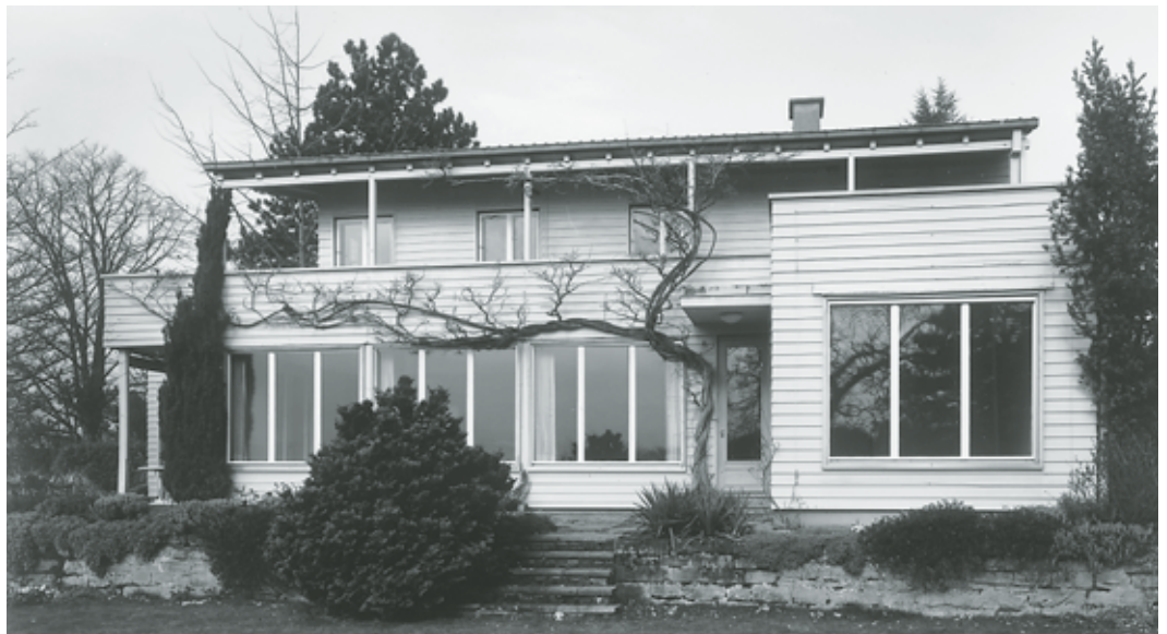
Ansicht von Osten (Gartenansicht) vor der Gesamtrenovation 1999. Gut erkennbar ist die nachträglich veränderte Befensterung bzw. Fensterteilung sowie die Überdachung des Lauben- ganges am Obergeschoss. Zustand März 1998. Foto- archiv HBA.
