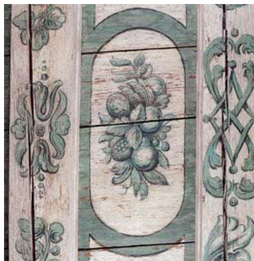
Links: Ausschnitt der bemalten Bretterbalkendecke aus der Zeit um 1600 im Salon des 2. Obergeschosses. Zustand nach der Entfernung des quer verlaufenden Unterzugs mit Stütze (vgl. Abb. S. 300), Mai 2003. Diese Verstärkung stammte von der letzten Renovation 1964–1965. Rechts: Ausschnitt der bemalten Bretterbalkendecke im Esszimmer des 2. Obergeschosses aus der Zeit um 1680. Zustand Mai 2003. Fotoarchiv HBA.
