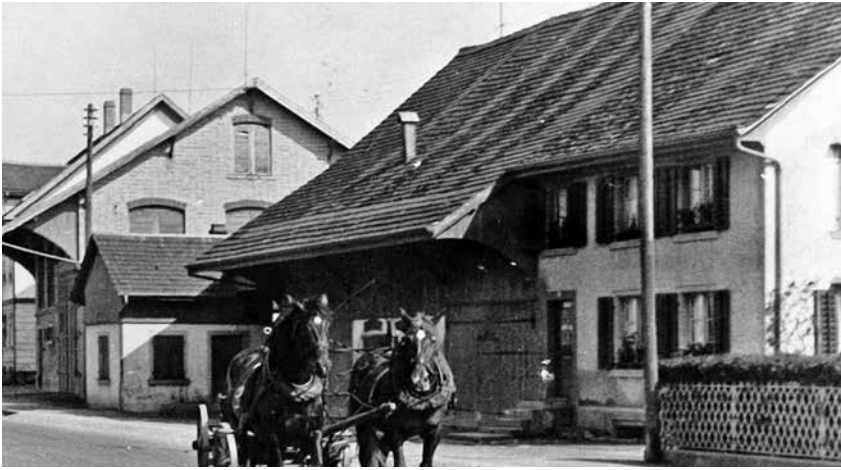
Das Stammhaus der Familie Meier an der Badenerstrasse 19, ca. 1940. Im Hintergrund die „Salzscheune“ und das Ortsmuseum.
