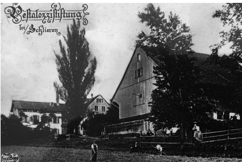
Die Pestalozzistiftung 1922. Das Gebäude links (Küche, Esssaal, Schulhaus) wurde 1984 abgerissen wegen Baufälligkeit. Scheune und Haupthaus stehen noch.
