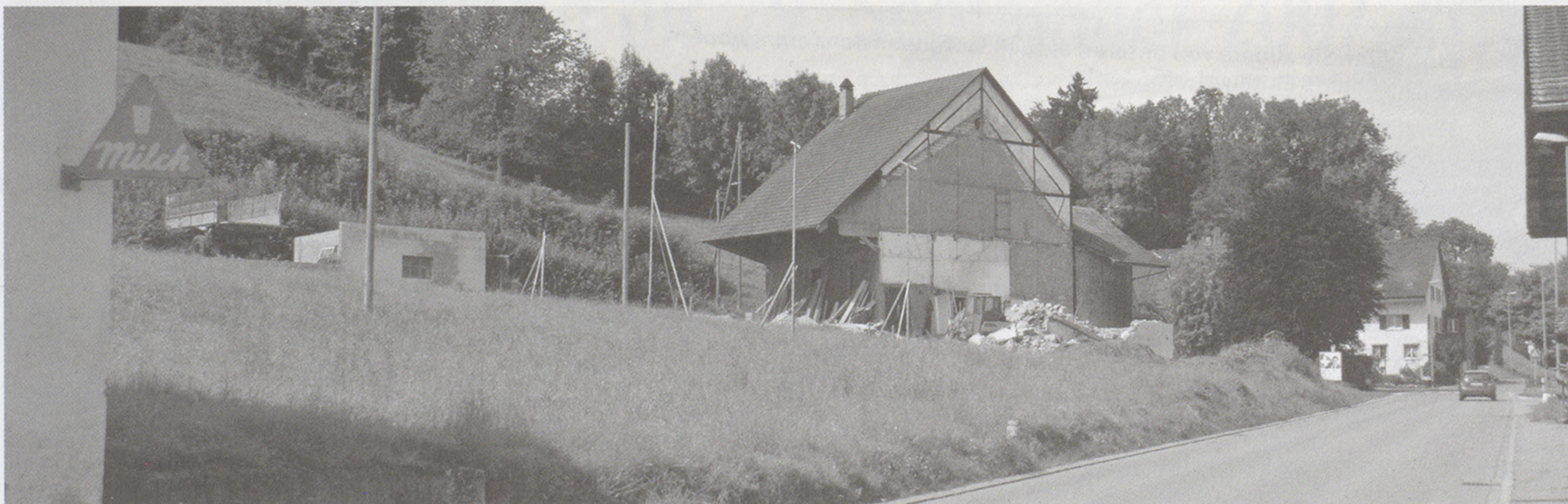
Anstelle des Bauernhofes entstehen Wohnungen auf der Wiese bergseits der Strasse.
