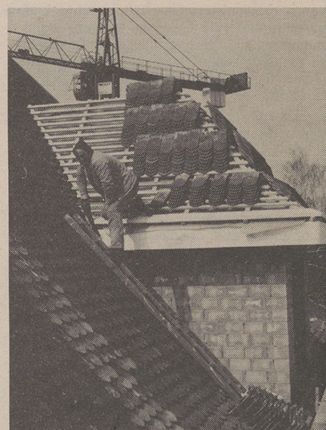
Dachdeckermeister H.R. Frehner an der Arbeit auf einer Lukarne. (Foto A. Baumann)
