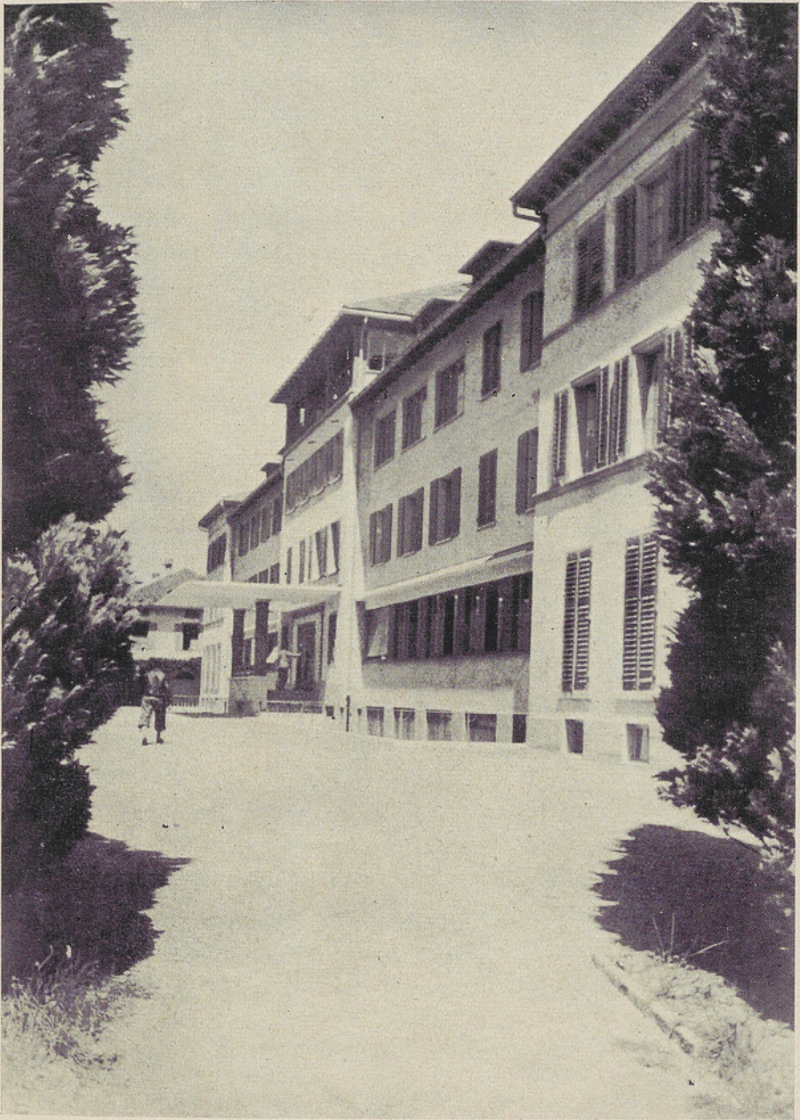
ALBISBRUNN : Vue des nouveaux bâtiments.
