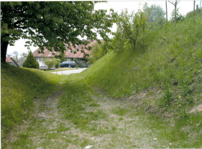
Der obere Teil des ehemaligen Hohlweges bei Hinteregg mit Blickrichtung auf das Niederdorf. Während dieser Teil heute stillgelegt ist, führt seine Verlängerung jenseits der Strasse Hinteregg - Neuguet immer noch als steile Zufahrt ins alte Niederdorf von Hinteregg hinab. (Foto: Gisela Goehrke)
