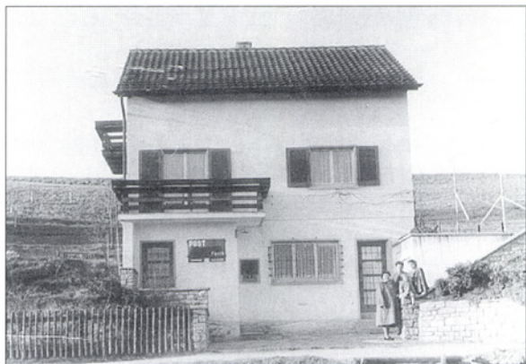
Die alte Post Forch am Kronenweg (auf Küsnachter Boden), in die Hans Arnet 1951 mit seiner Familie zügelte. Das Postbüro war im Erdgeschoss, die Posthalterwohnung im ersten Stockwerk.
