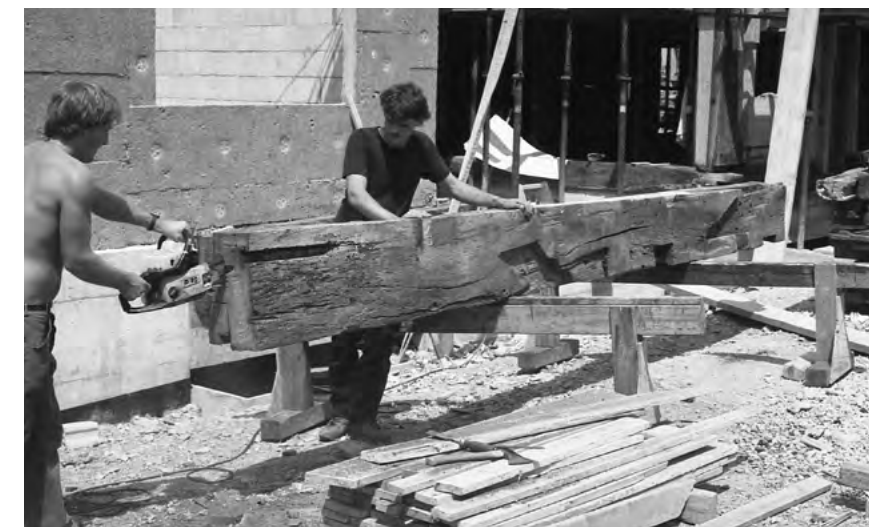
Die grossen Eichenbalken für die Auflager werden an Ort und Stelle bearbeitet
