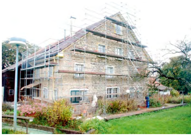
Die Südfassade während der Sanierung
