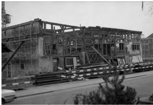
Kurz vor oder nach 1900 fand bekanntlich ein grosser Umbau des Stürmeierhuus' statt. Das Dach wurde abgetragen. Durch die Erhöhung der Konstruktion um 1,2m ermöglichte man ein drittes Geschoss. Gleichzeitig schuf man auch im ersten Obergeschoss auf der «Brügi» (Heubühne) neue Kammern. Die Südfassade dieser Erweiterungen wurde im damals bereits weit verbreiteten Fachwerkbau erstellt.
