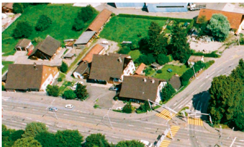
Luftaufnahme der drei Häuser Badenerstrasse 12, 18 und 20
