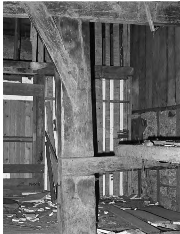
Durch den Umbau kam das Dach 1,2 Meter höher zu liegen. Die vertikalen Dachträger (Kniestöcke) mussten also um ebenso viel verlängert werden. Dazu setzte man neue Balkenstücke auf die alten Träger. Das verlangte saubere Schnitte und solide Verbindungen. Hut ab vor den damaligen Zimmerleuten!
