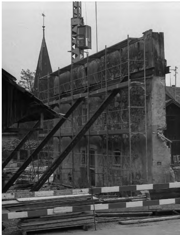
Der Westgiebel wurde 1900 bis zur neuen Höhe weiter mit Bruchsteinen gemauert.
