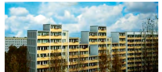
Die Erfindung des Eisenbetons liess die Häuser in den Himmel wachsen.
