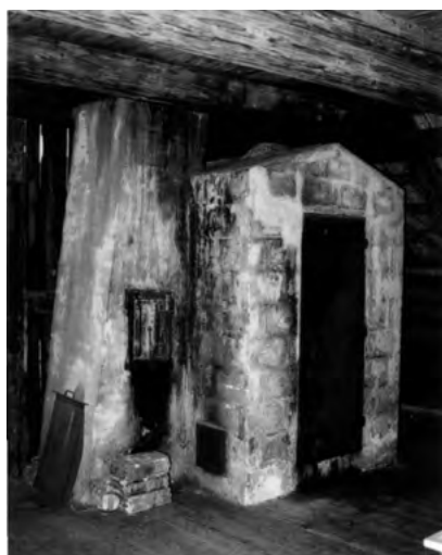
Im Dachraum steht neben dem Kamin-zug eine Räucherammer.
