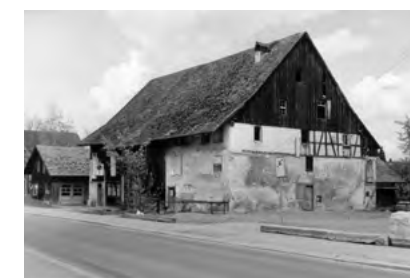
1984, unmittelbar vor dem Abbruch bzw. vor der Totalsanierung
