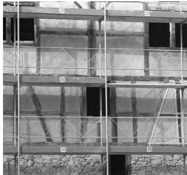
Die Erhöhung des Ostgiebels erfolgte – wohl in Fortsetzung der Südfassade – in Fachwerk.
