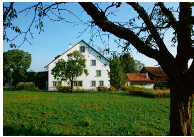
Die neue Südfassade
