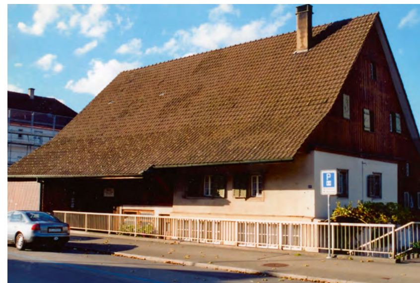
Haus Badenerstrasse 20 von Südost
