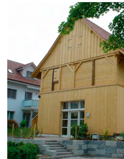
... und nach dem Umbau
