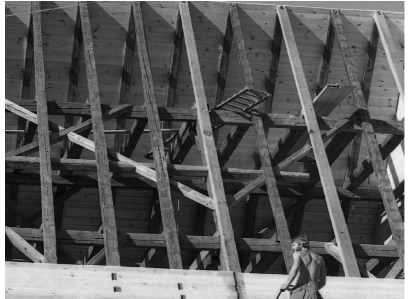
Dachsparren, Pfetten und Windverbände (diagonal)
