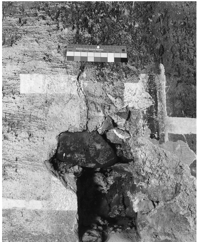
Abb. 29. Winterthur. Marktgasse 44. 2. Obergeschoss: östliche Brandmauer mit Balkenloch und Farbfassung einer zeitweiligen Trennwand barocker Art des 17./18. Jh.
