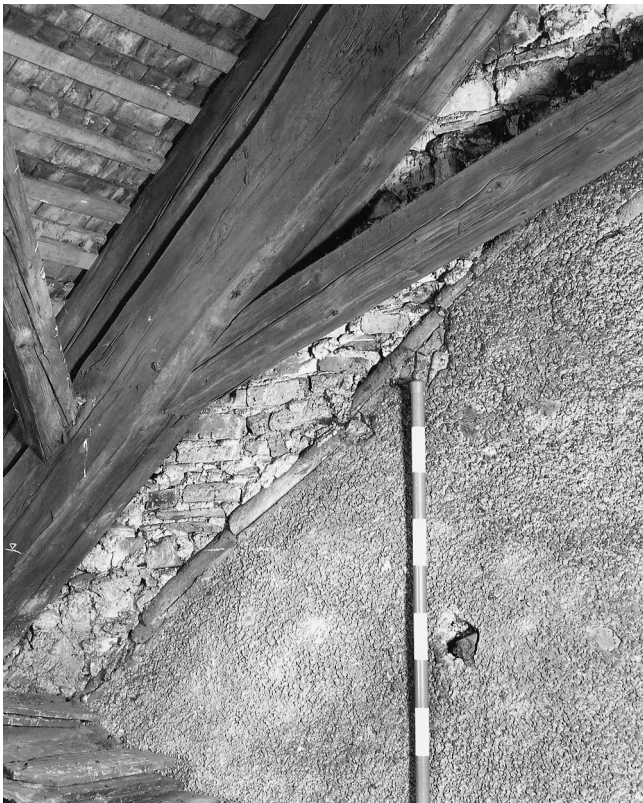
Abb. 28. Winterthur. Marktgasse 44. Oberes Dachgeschoss, östliche Brandmauer: zeitweilige Giebelfassade des östlichen Nachbarhauses mit Aussenputz und vordachloser Klosterziegel-Eindeckung; heutiger Dachstuhl von 1815.
