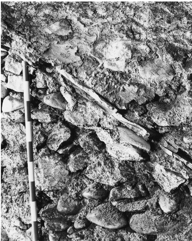
Abb. 39. Winterthur. Marktgasse 44. Oberes Dachgeschoss: östliche Brandmauer mit der Dachschräge von 1338 und zugehörigen Flachziegeln.
