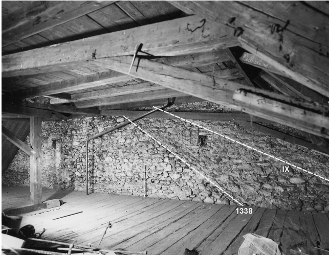
Abb. 36. Winterthur. Marktgasse 44. Unteres Dachgeschoss: östliche Brandmauer mit der Dachschräge von 1338 und zwei späteren Erhöhungen; heutiger Dachstuhl von 1815.
