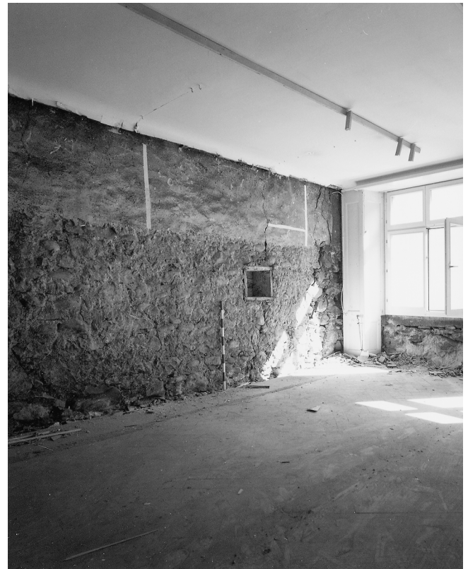
Abb. 27. Winterthur. Marktgasse 44. 2. Obergeschoss, Südostecke: östliche Brandmauer von 1338 mit zeitgleicher Wandnische; von Nordwesten.
