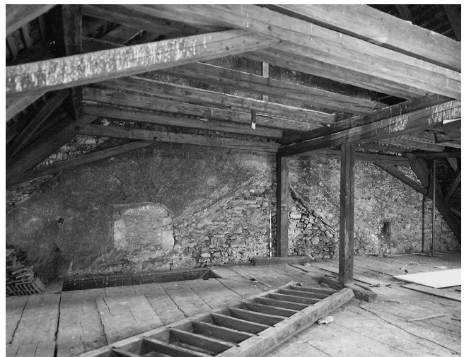
Abb. 35. Winterthur. Marktgasse 44. Oberes Dachgeschoss: östliche Brandmauer mit Giebel von 1338 und späteren Erhöhungen; heutiger Dachstuhl von 1815.
