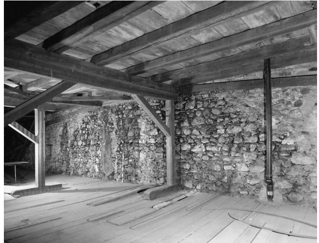
Abb. 38. Winterthur. Marktgasse 44. Unteres Dachgeschoss: westliche Brandmauer von 1338 mit zugehöriger Dachschräge (rechts); heutiger Dachstuhl von 1815.
