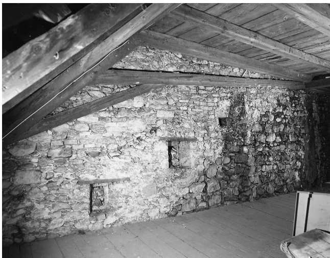
Abb. 33. Winterthur. Marktgasse 44. Unteres Dachgeschoss: westliche Brandmauer mit Dachschräge von 1338 (rechts) und einer späteren Anhebung mit drei Fensterchen; heutiger Dachstuhl von 1815.
