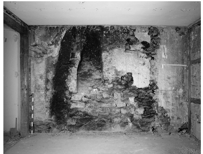
Abb. 26. Winterthur. Marktgasse 44. 2. Obergeschoss: westliche Brandmauer von 1338 mit zeitgleichem Kaminzug Pos. 681 und Verrussung durch einen jüngeren Kaminzug, Pos 682 (links); über dem Meterstab Farbfassung des 17./18. Jh., Pos. 680.
