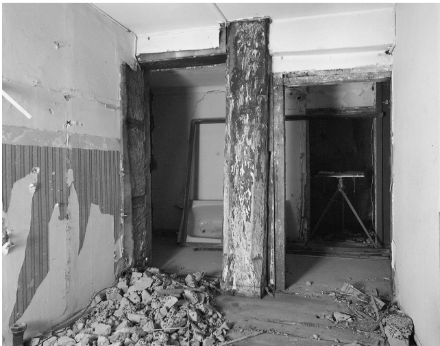
Abb. 24. Winterthur. Marktgasse 44. 2. Obergeschoss: Jochsäule von 1336d, Ostansicht.
