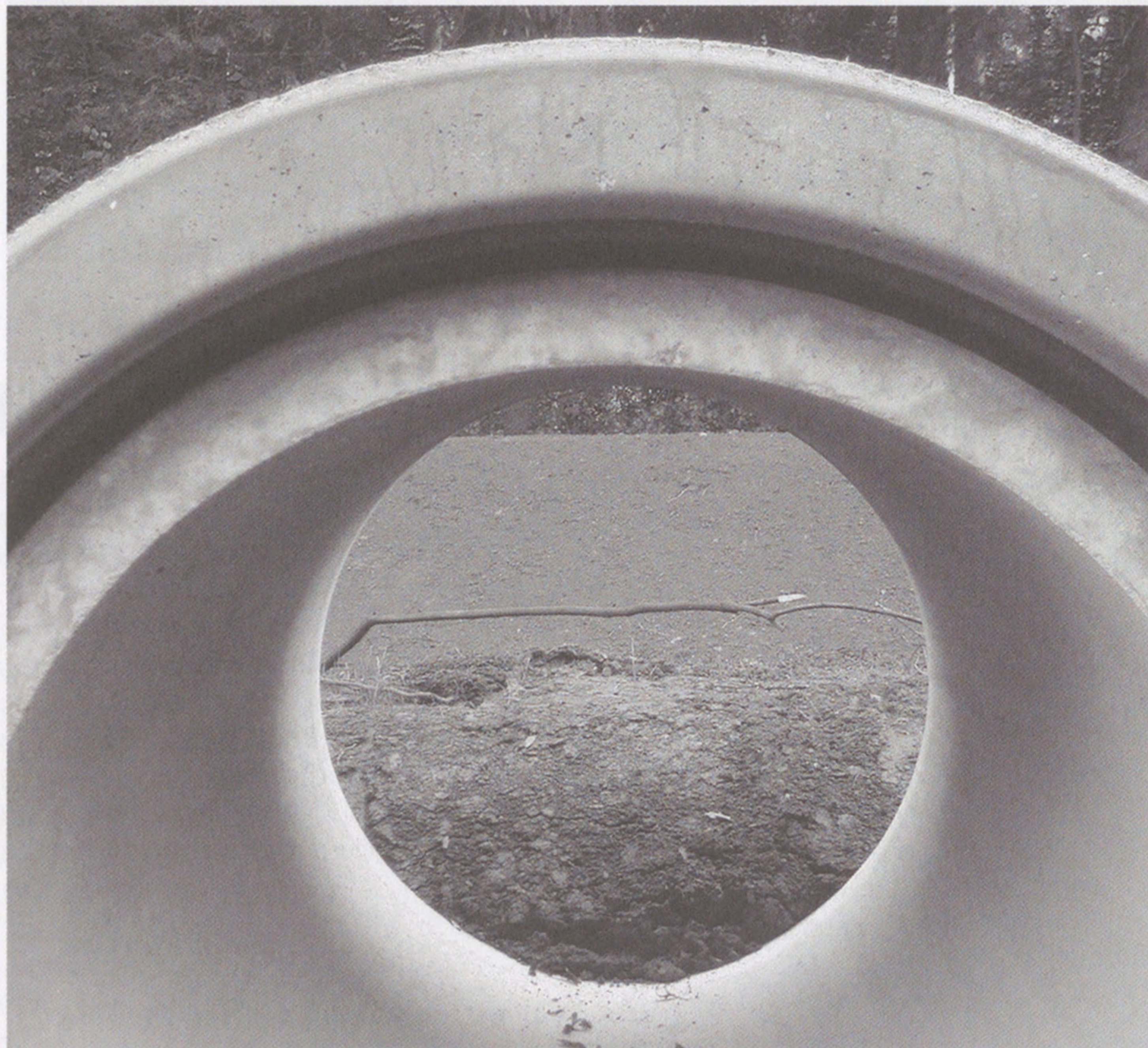
Als Schutz vor neuen Überschwemmungen werden jetzt riesige Betonröhren mit fast mannshohem Durchmesser in der Waldlichtung Tanneten verlegt. (Foto: kim)
