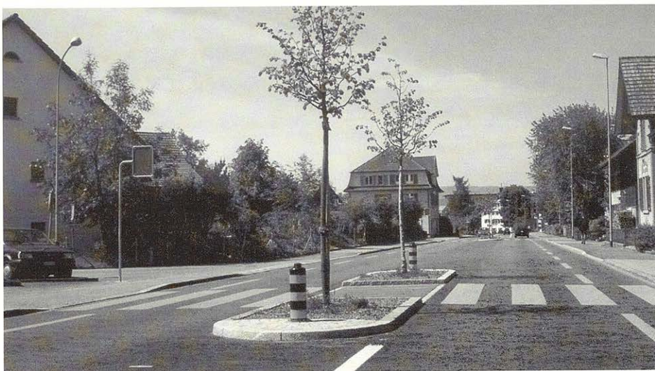
Im Frühjahr 2001 werden mitten in der Zürichstrasse Bäume gepflanzt: Eine optische Verschönerung und ein Beitrag zur Geschwindigkeitsreduktion.
