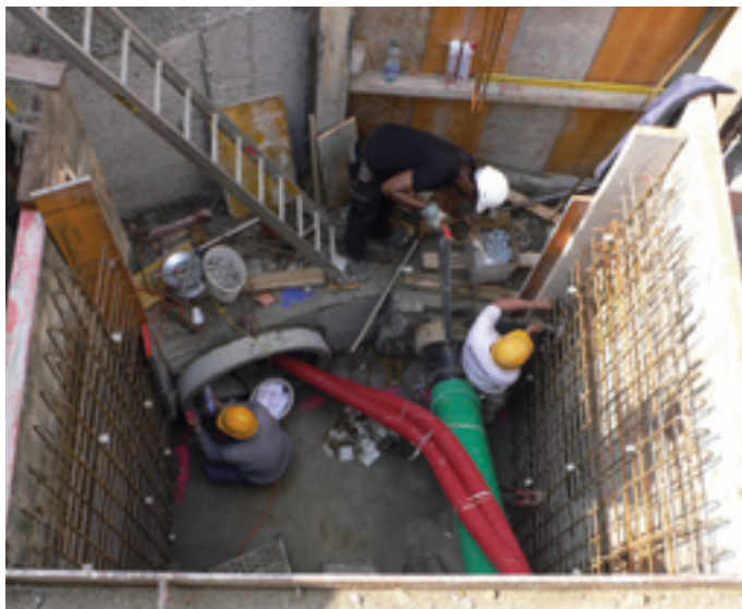
Schachtausbau an der Werdstrasse
