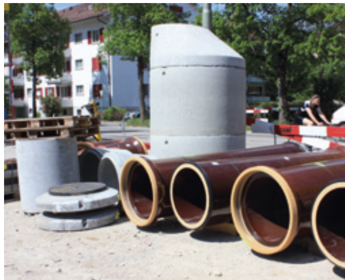
Die letzten Schächte und Rohre warten auf die Verlegung
