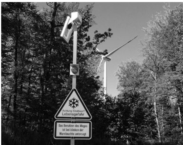
Impression aus dem Gebiet des Verenafohren-Windpark (DE), welche die Waldzerstörung aufzeigt.
