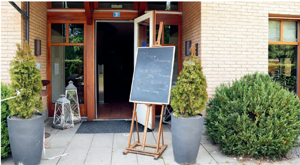
1994 erbaut, muss die «Schifflande» nun umfassend saniert werden. Die Arbeiten dauern circa ein Jahr. Bild: Dörte Welti
