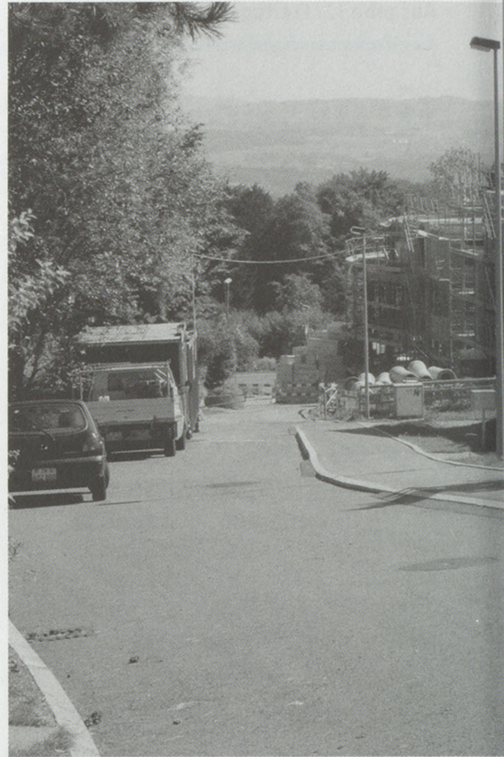
Im Gassacher wird das Trottoir nach dem Schulhaus jetzt durchgehend gebaut. (Fotos: sl)
