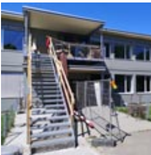
Der Umbau nimm langsam Formen an.
