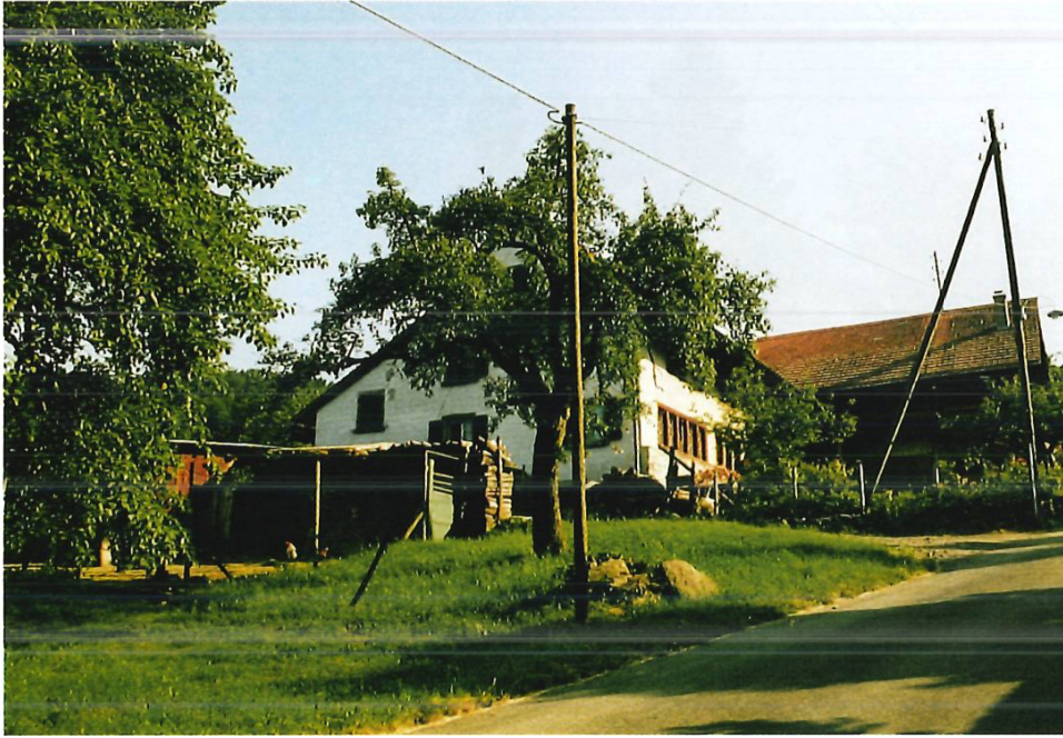
Hart an der Pfannenstielstrasse der heimelige Hof Roren von Jakob Dohner.
