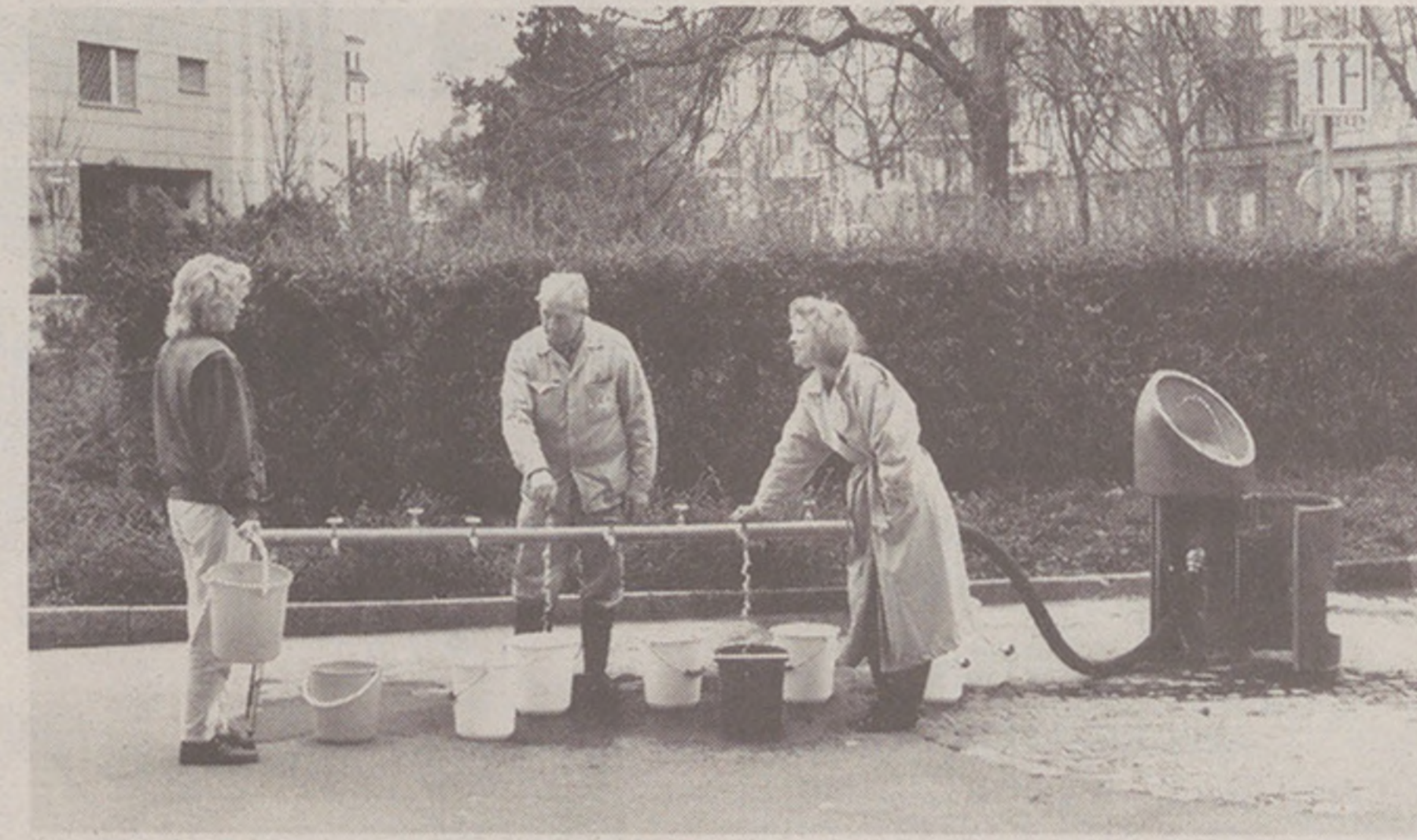
Geöffneter Notwasserbrunnen mit Zapfstelle und Verteilbatterie
