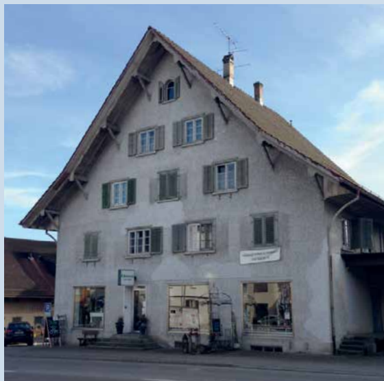
Das ehemalige Wahrzeichen der Landwirtschaftlichen Genossenschaft Illnau entzweit die Gemüter: Sanierung oder Abbruch?
