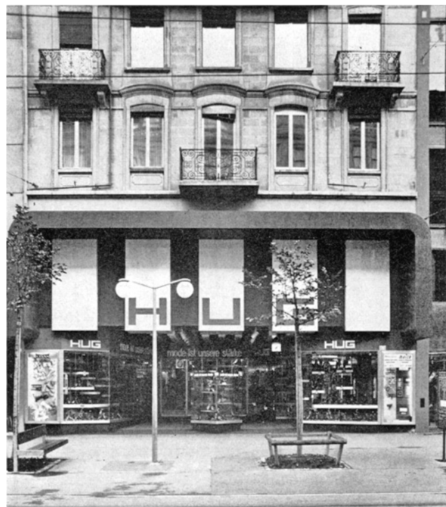
Bahnhofstrasse 76. Neue Erdgeschosszone.
