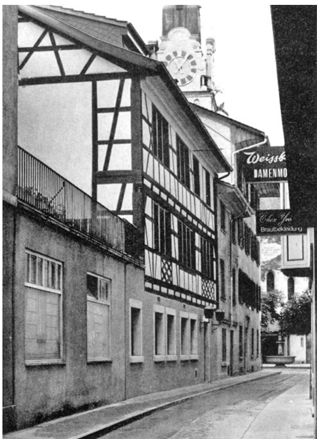
Winterthur. Altstadt. Schulgasse 3. Renovierte Riegelfassade.
