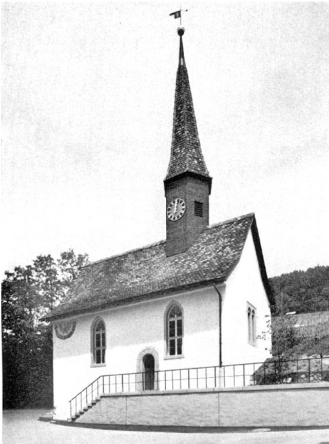
Laufen-Uhwiesen. Uhriesen. Kapelle nach der Restaurierung 1972/74. Aus Süden.
