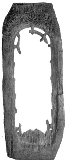
Illnau-Effretikon. Rikon. Kapelle. Fensterrahmen aus Eichenholz. Original. Aussenseite. \frac{1}{10} natürlicher Grösse.
