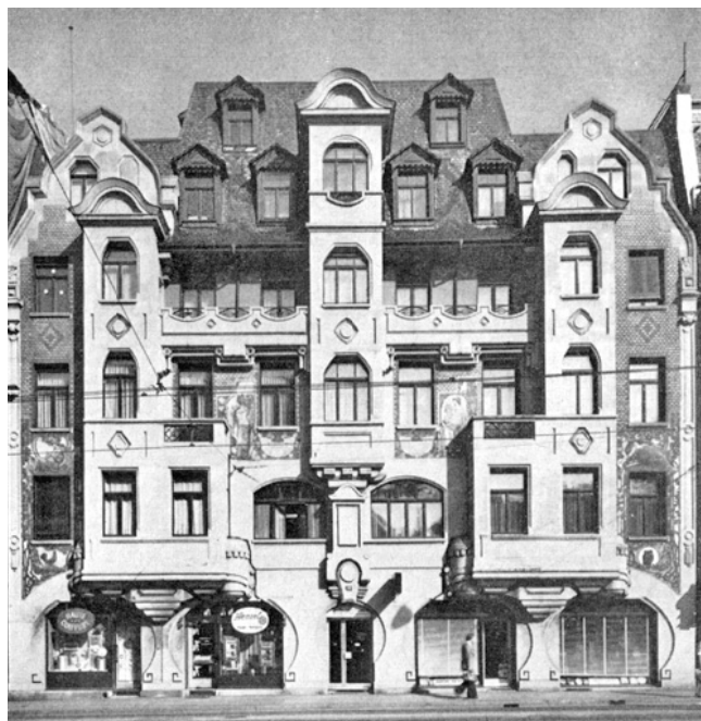
Bleicherweg 45. Ansicht gegen den Bleicherweg.
