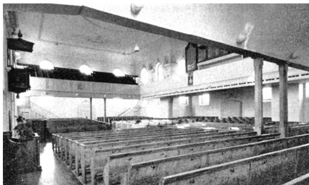
Gossau. Reformierte Kirche. Inneres vor der Restaurierung 1970.
