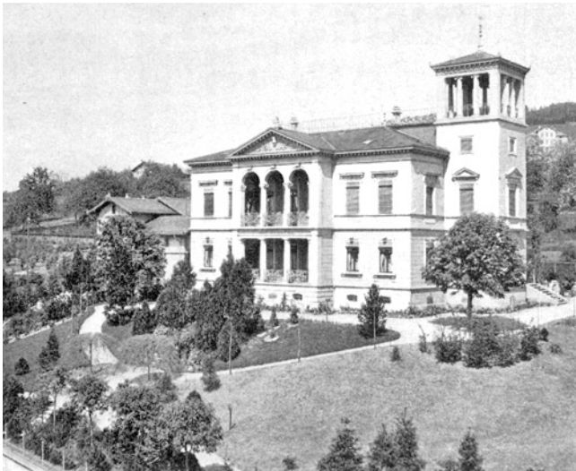
Sumatrastrasse 36. Villa «Sumatra». a) Ansicht gegen die Weinbergstrasse. Ursprünglicher Zustand; b) Treppenhaus nach dem Umbau für J. Maggi.
