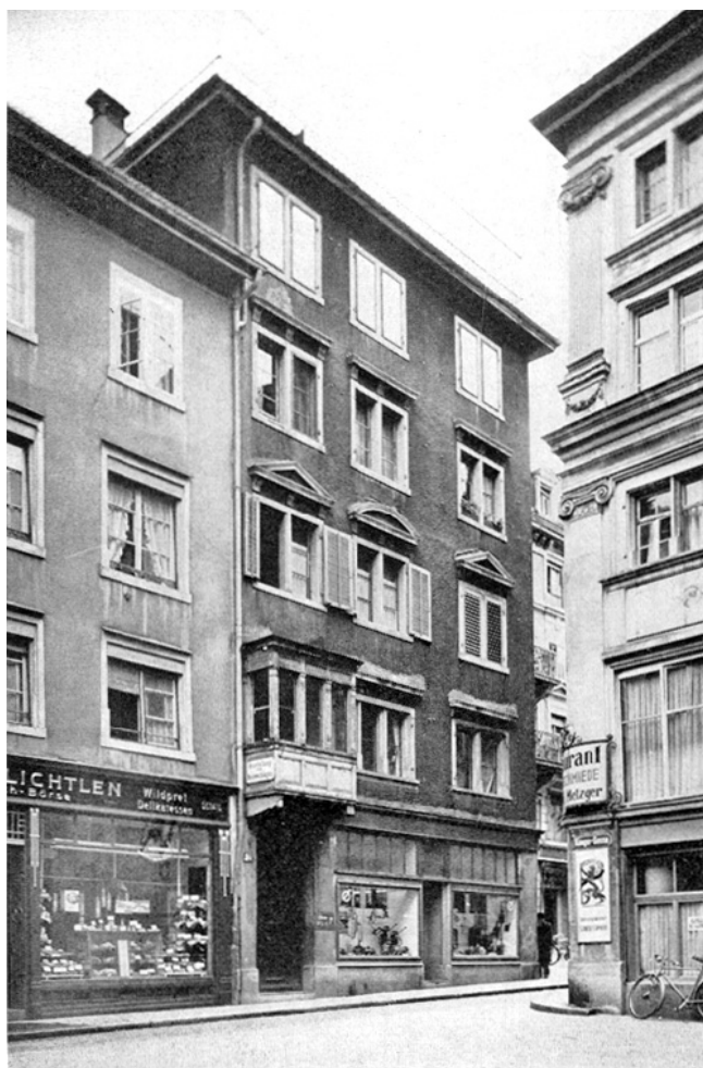
Niederdorfstrasse 20. Vor der Renovation.
