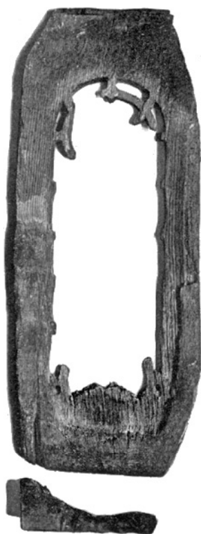
Illnau-Effretikon. Rikon. Kapelle. Oben: Originalfensterrahmen aus Eichenholz (Aussenseite). Unten: Angekohltes Fragment eines solchen. \frac{1}{10} natürlicher Grösse.
