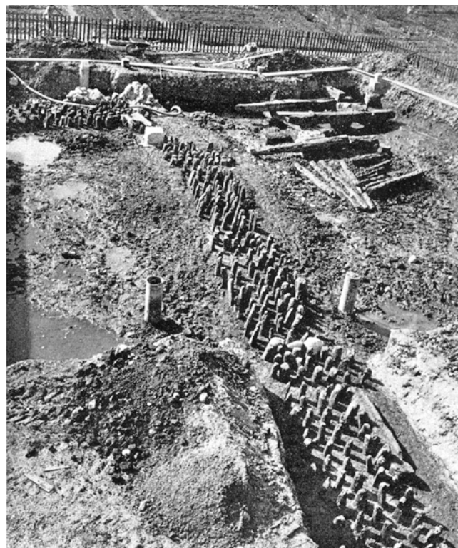
Pfäffikon. Burgwies. Ehemalige Wasserburg. Gesamtübersicht des Pfahlrostes der nördlichen Burgmauer und der Nordwestecke aus Osten.
