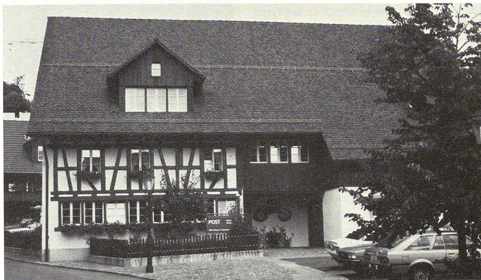
Seit 1983 befindet sich die Post wieder im neuen «alten Schurterhaus».
