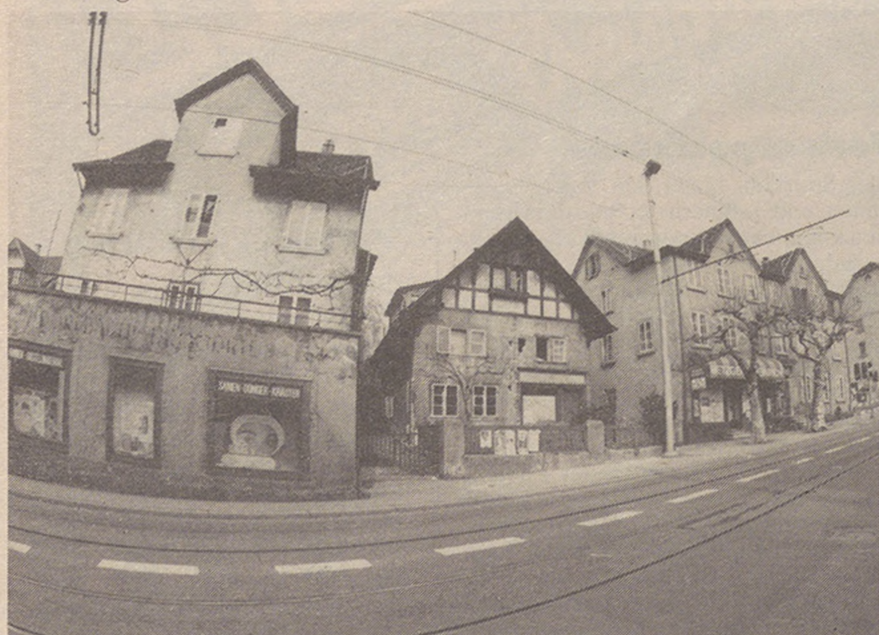
Die ehemalige Dorfbach-Drogerie (Limmattalstrasse 186/188), das kleine Riegelhaus (Limmattalstrasse 182/184) sowie die ehemalige Metzgerei Heinrich (Limmattalstrasse 180) im März 1987, einige Monate vor ihrem Abbruch.
