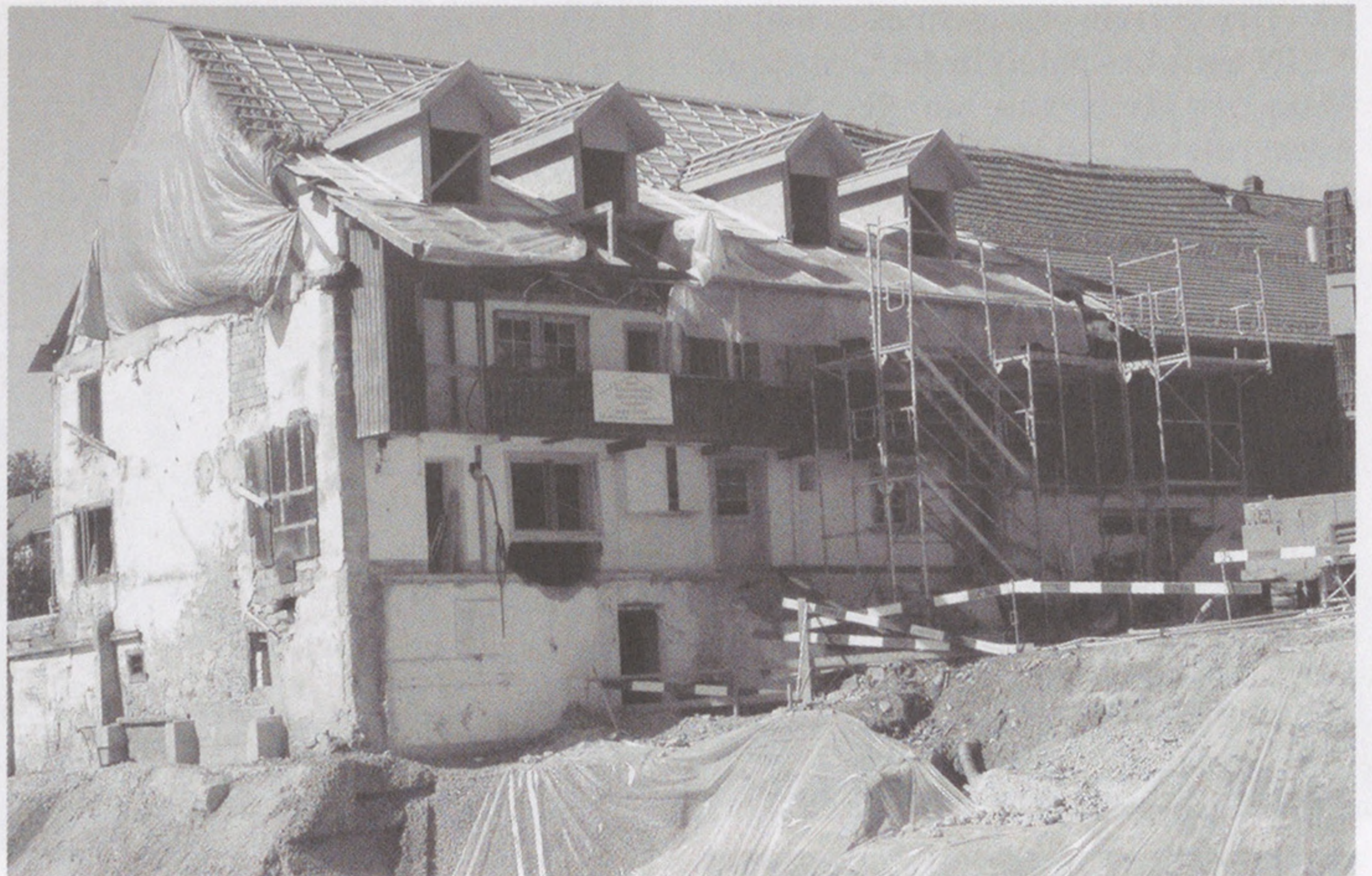
Das zurzeit ausgehöhlt ehemalige Bauernhaus in Aesch. Hier wird der Dachbalken mit der Inschrift wieder seinen Platz finden.
