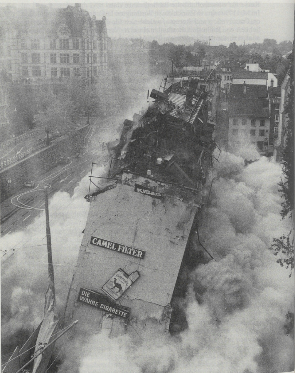
«Baubeginn» der neuen Zentralbibliothek am 19. Mai 1990.
