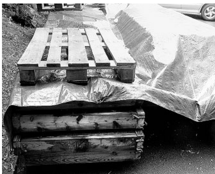
Sorgen für Diskussionen: für die Montage bereit liegende Lärmschutzwände.
