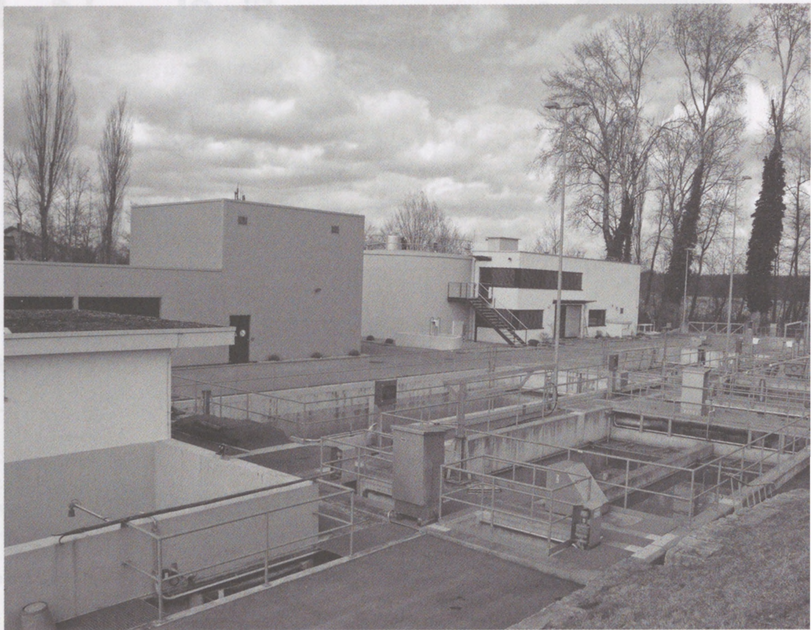
Kläranlage Bachwis in Fällanden.
