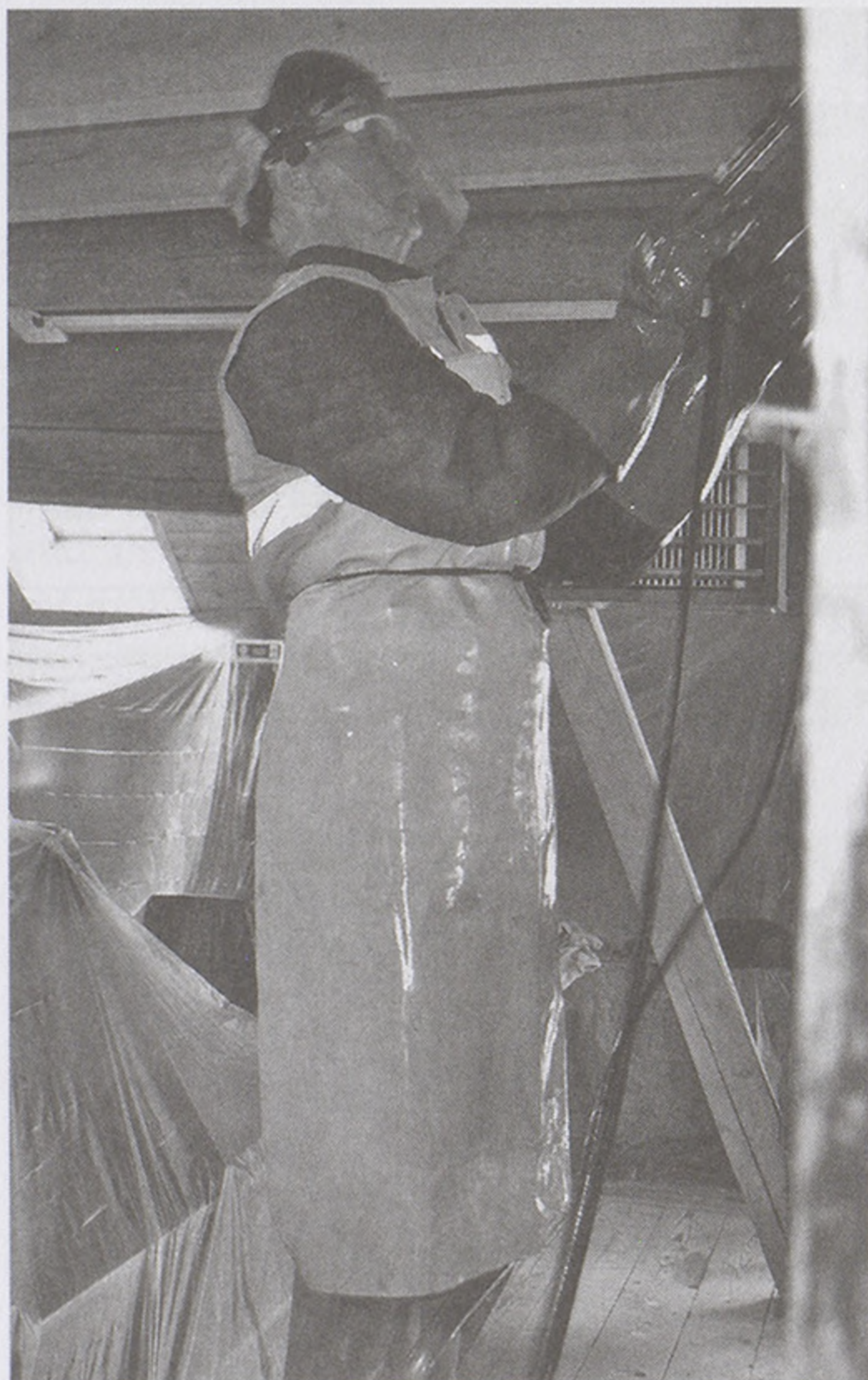
Die beiden Schädlingsbekämpfer pressen abwechselnd in jeden einzelnen Eingang zu einem Holzwurmhang eine für die Schädlinge tödliche Flüssigkeit hinein.
