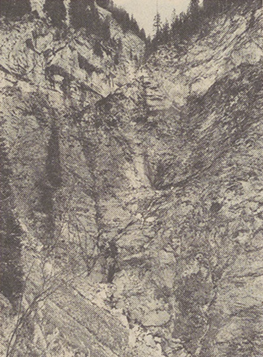
... und nach dem Bau der Kraftwerke Sarganserland
