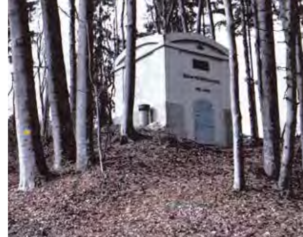
Das alte Reservoir Röhrenmoos, seit 1973 ausser Betrieb.
