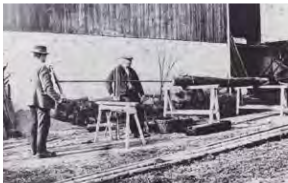
Teuchelbohrung durch Drechsler Benz.
