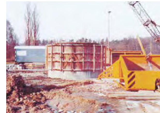
Unten: Einsatz von Zivilschutzpumpen im Grundwasserbrunnen Schönenwerd im heissen Sommer 1976.
