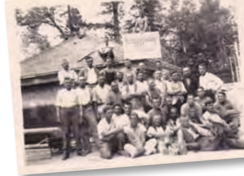
Oben: Bauarbeiter vor dem Reservoir Sonnenrain 1933 in der schwierigen Zeit der Weltwirtschaftskrise.
