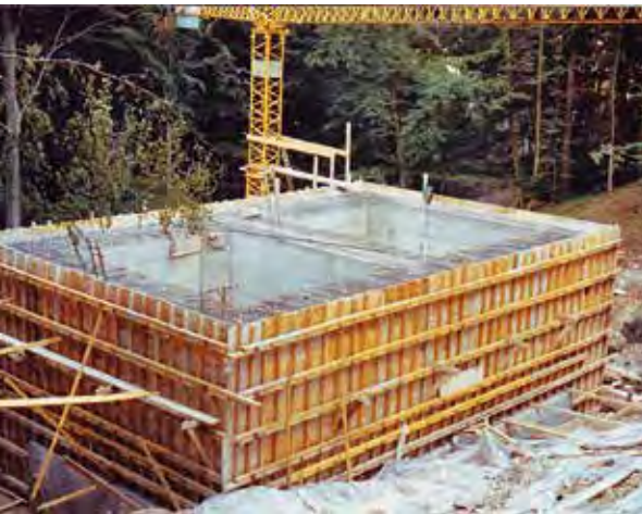
Oben: Die Erweiterung des Reservoirs Junkholz um 4000 m 3 im Januar 1972.
