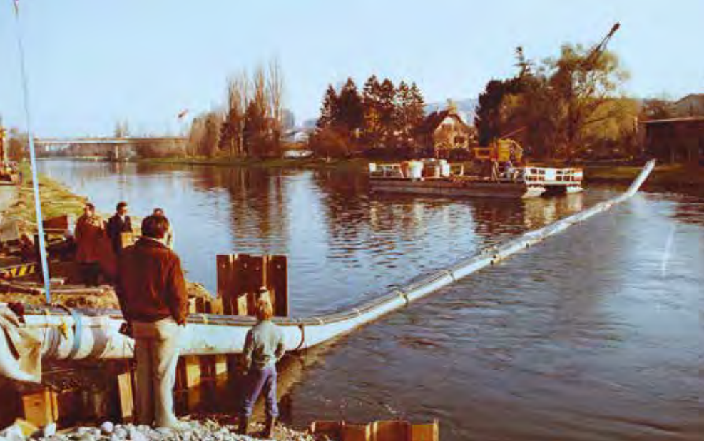
Düker in Stahlrohren, Durchmesser 600 Millimeter, vor dem Absenken in die Limmat.
