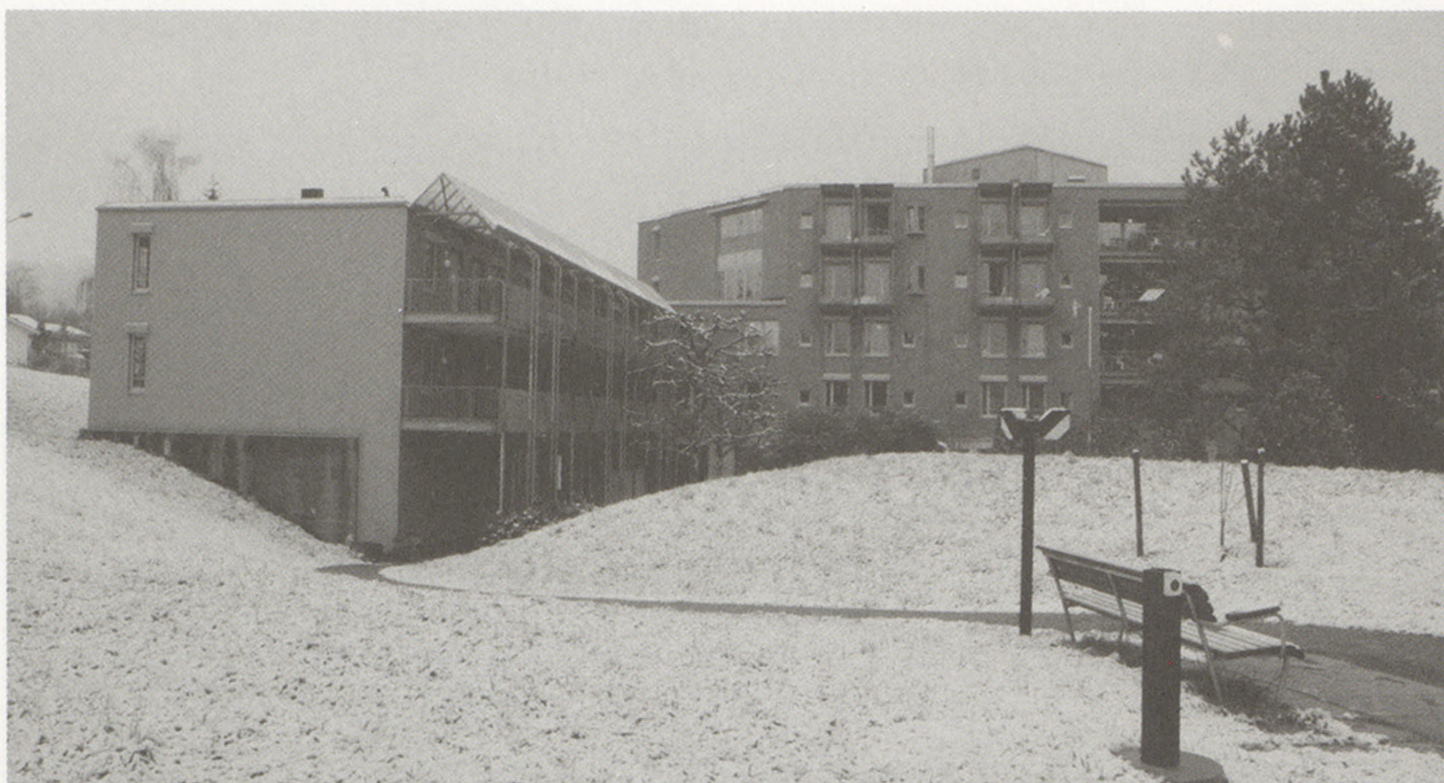
Am Südtrakt wird ein definitives Treppenhaus samt Lift angebaut.
