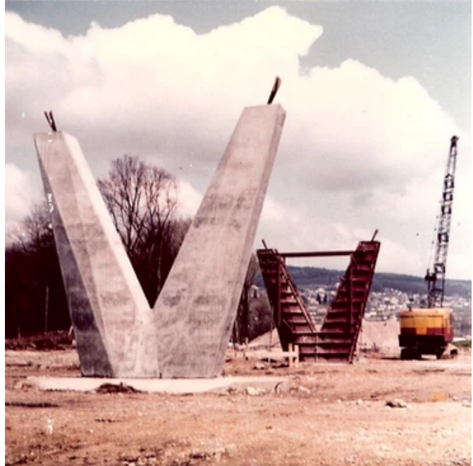
links: geschaltete Autobahnstützen für Sihlhochstrasse bei der Lessingstrasse (1968)
