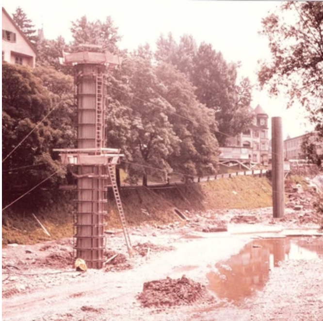
links: geschaltete Autobahnstützen für Sihlhochstrasse bei der Lessingstrasse (1968)
