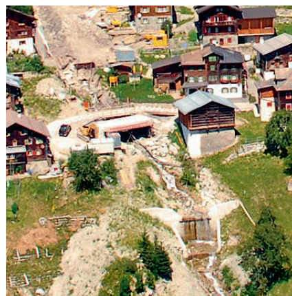
Der Abschnitt unter der Hauptbrücke kann nun doch auch noch saniert werden.
