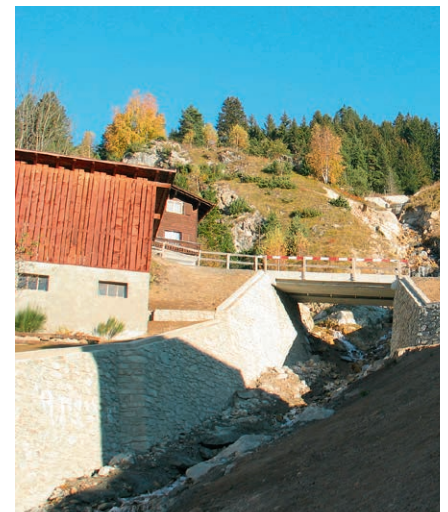
Im oberen Teil sind die Sanierungsarbeiten bereits abgeschlossen.
