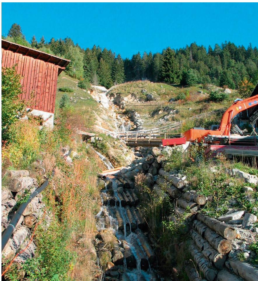
Das provisorische Bachbett aus Stämmen musste im Frühjahr 2007 der definitiven Lösung weichen.
