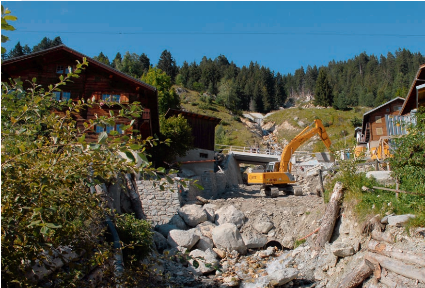
Im vergangenen Sommer glich Schlans einer einzigen Grossbaustelle
