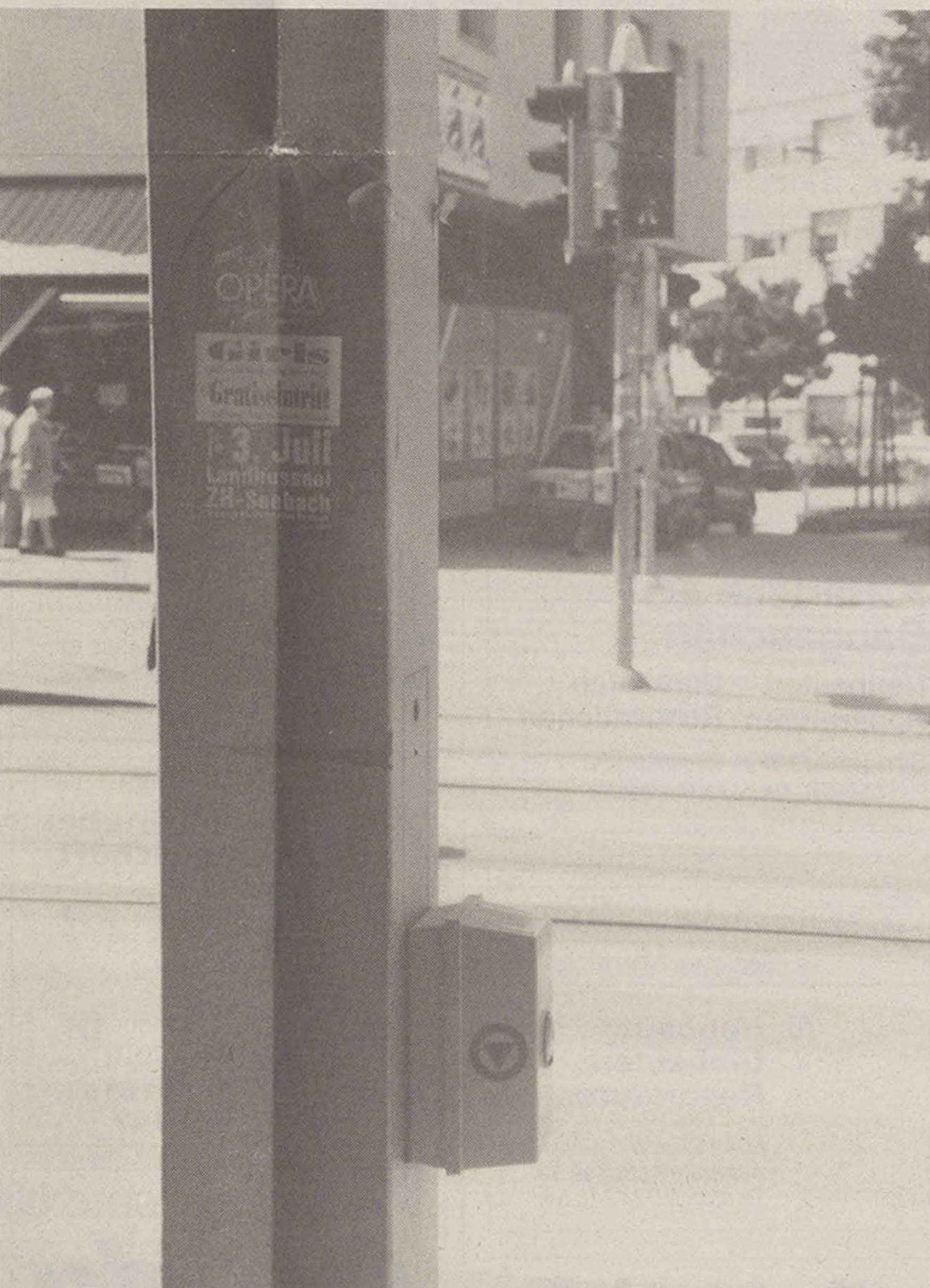
An der Strassenkreuzung am Meierhofplatz sind gleich drei solcher Vibrations-Signalanlagen angebracht, an jedem Teilübergang eine.
