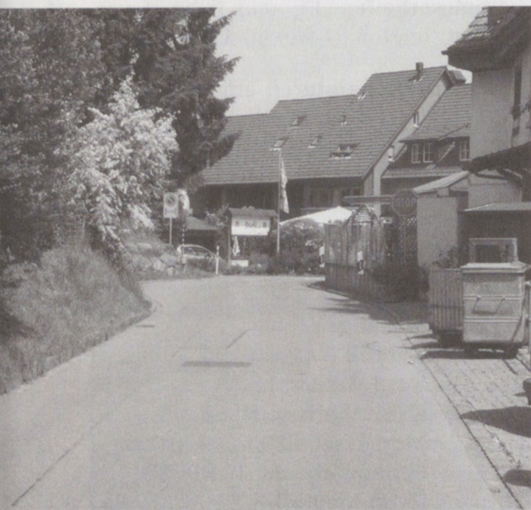
Die Eggstrasse bekommt ein Trottoir.
