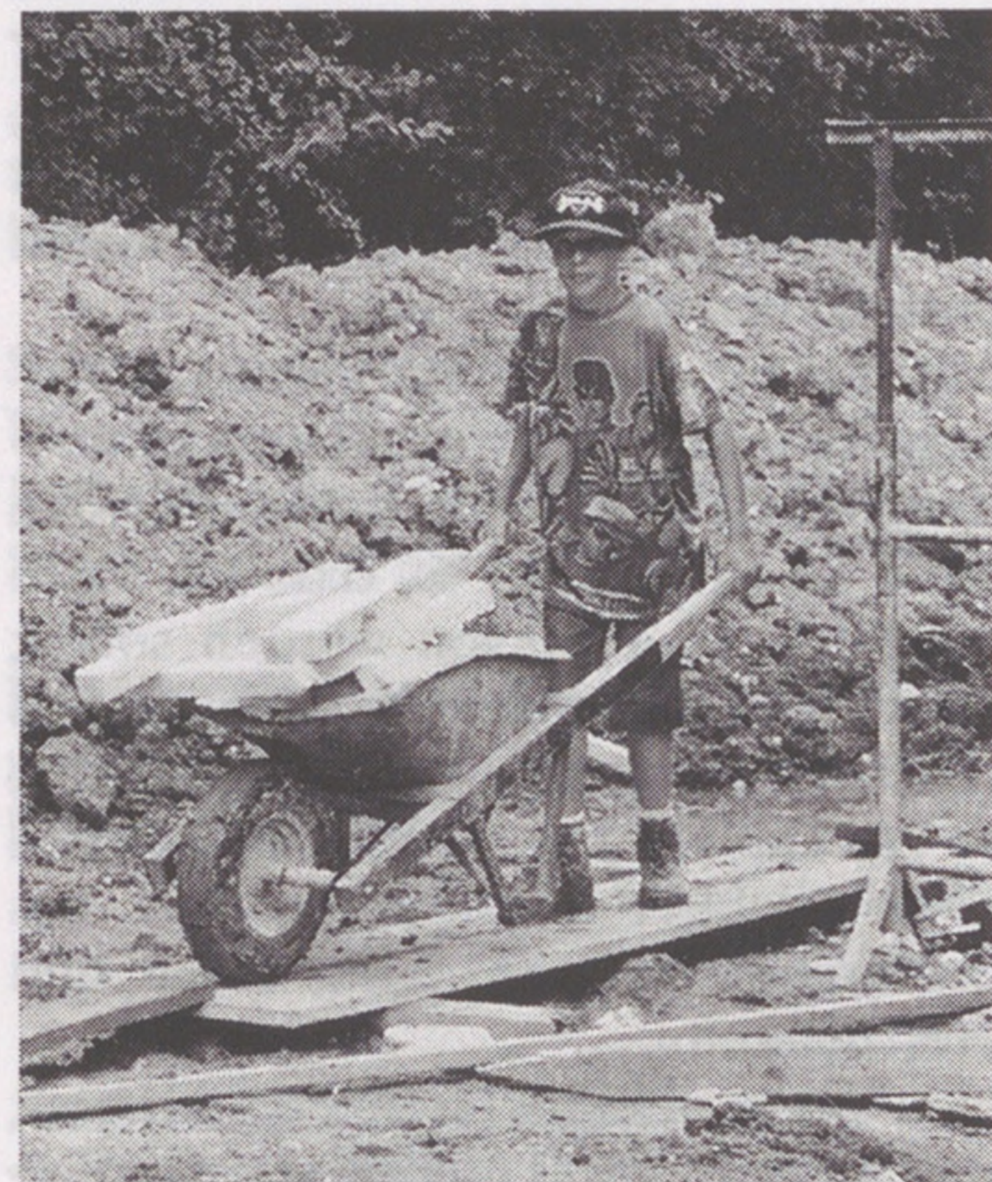
Unzählige Fotos dokumentieren den Bau des Pfadiheims
