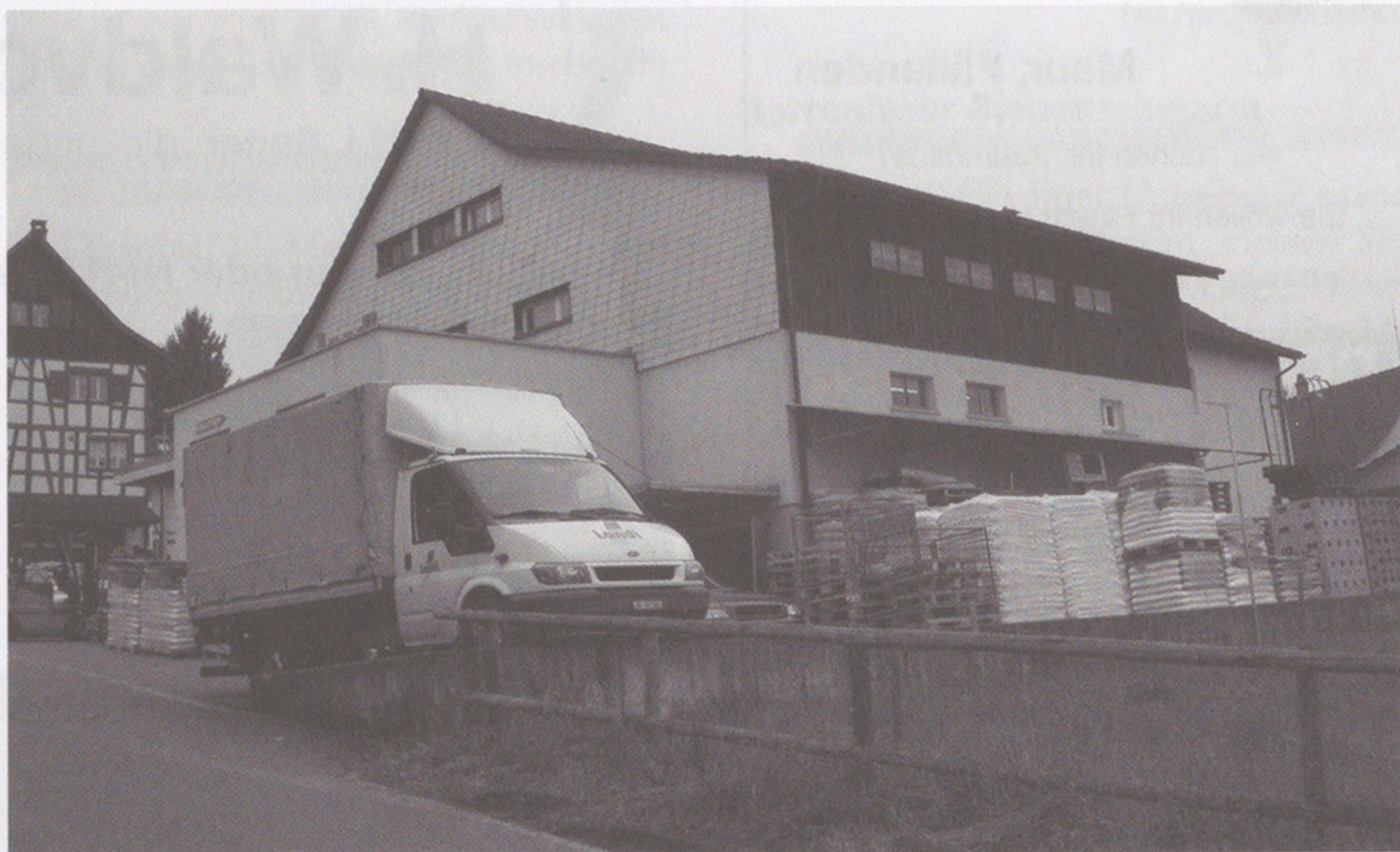
Der Lagerraum der Landi hinter dem Laden in Maur wird noch diesen Sommer überdacht werden, der Verkaufsraum so um 48 m 2 erweitert. (Foto: kim)
