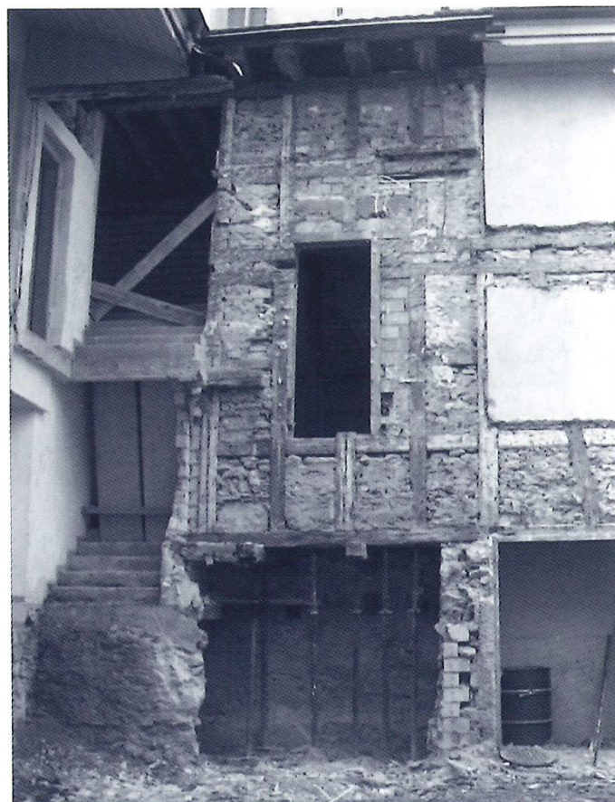
Freigelegtes Fachwerk gegen Norden.
