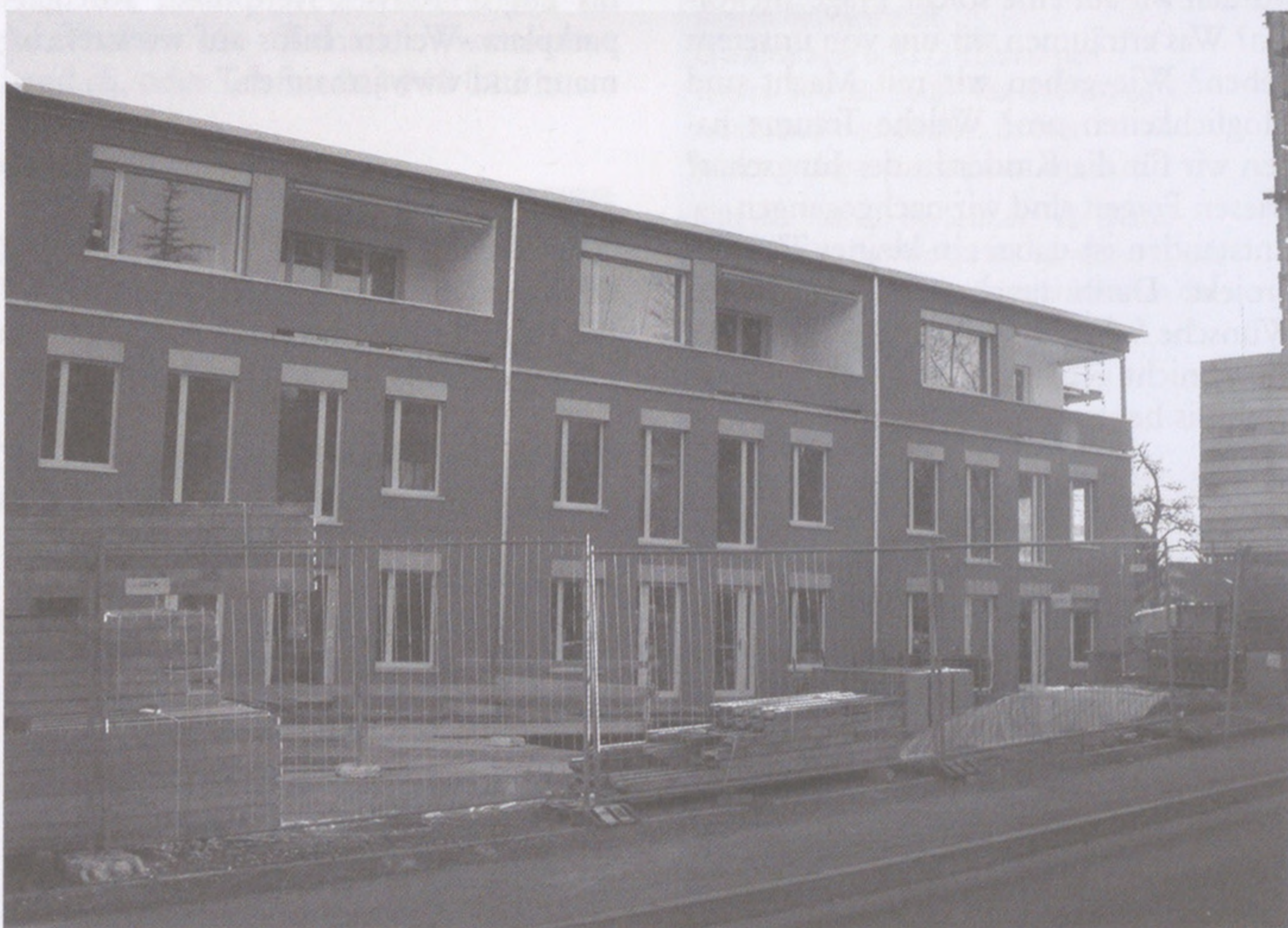
Die Modernisierungsarbeiten am Zollingerheim machen, mittlerweile auch von aussen sichtbar, grosse Fortschritte. (Foto: kim)
