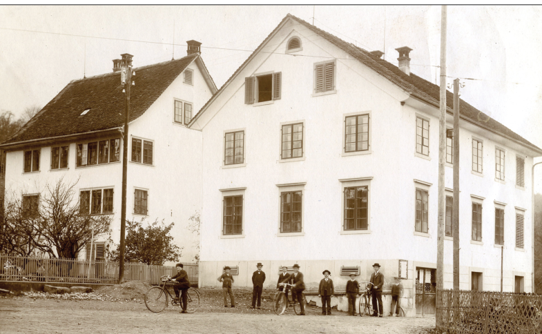
02 Pfarrhaus und altes Schulhaus um 1930 mit neun kopfbedeckten, männlichen Statisten. Die erste Türe an der Längsseite des Schulhauses war der Zugang zum Geräteraum der Feuerwehr.
