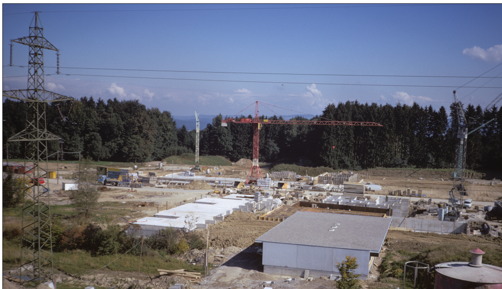
25 Mitten in einer Wüste von Baugruben, Erdhaufen und Schotterpisten steht der Kindergarten Buechwis (Haus 6) schon 1972 für den Unterricht bereit.
