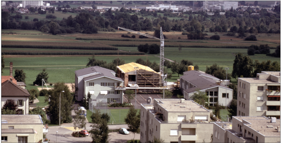
06 Baustelle Haus B (1971)
