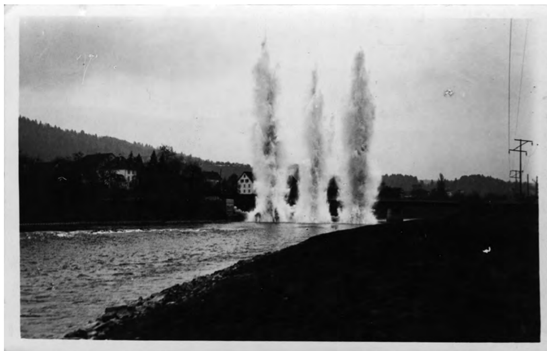
94 ca. 1935 Sprengung der Brückenfundamente
