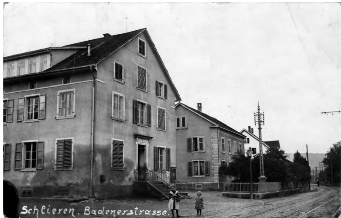
43 © 24.7.1917 Altes Schulhaus an der Badenerstrasse
