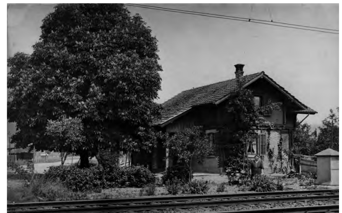
39 ca. 1930: Barrierenwärterhäuschen nördlich der SBB-Linie an der ehemaligen Allmendstrasse
