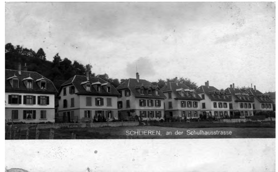
85 © 27.10.1915 Schulstrasse / die Sieben Häuschen
