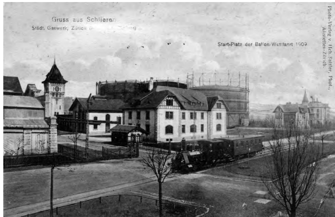
52 © 10.3.1911 Gaswerk mit Arbeiterzug
