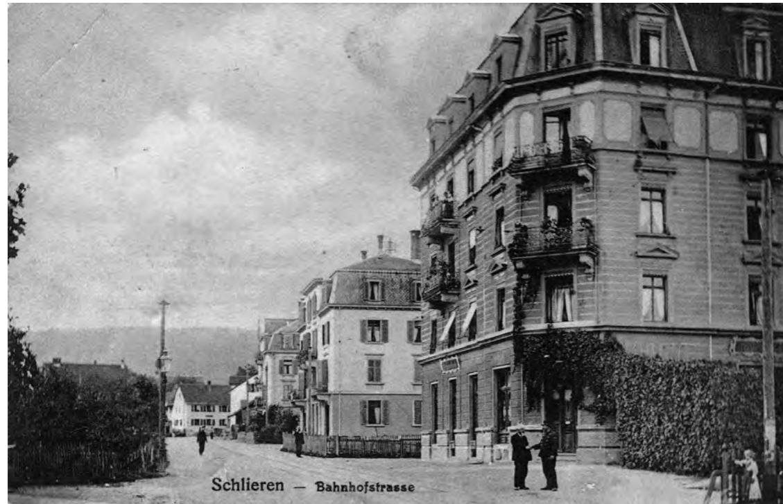
65 © 9.7.1915 Restaurant Krone an der Bahnhofstrasse, von Norden her
