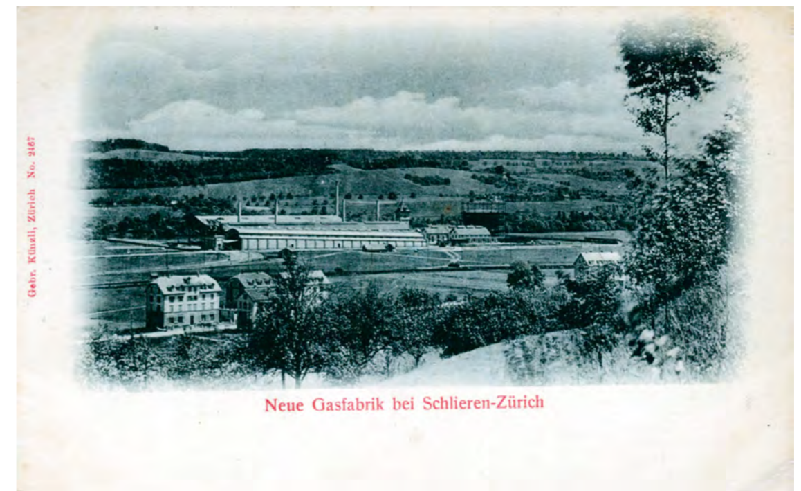
26 ca. 1910 Josefsheim (links), Zürcherstrasse und Gaswerk
