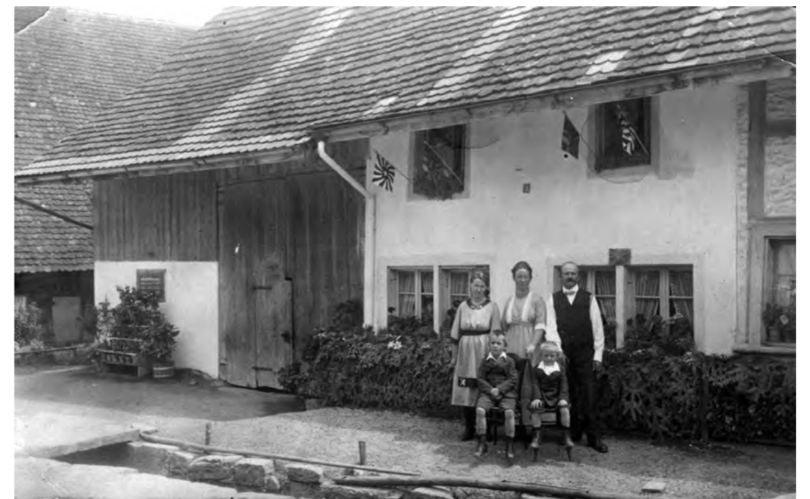
76 © 30.8.1920 Haus am Bach, Sägestrasse von Westen
