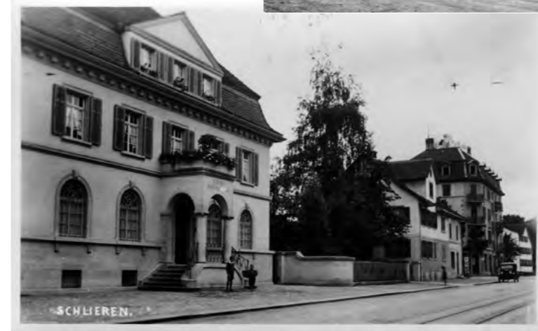
84 © 16.11.1951 Zürcherstrasse 20 alte Kantonbank
