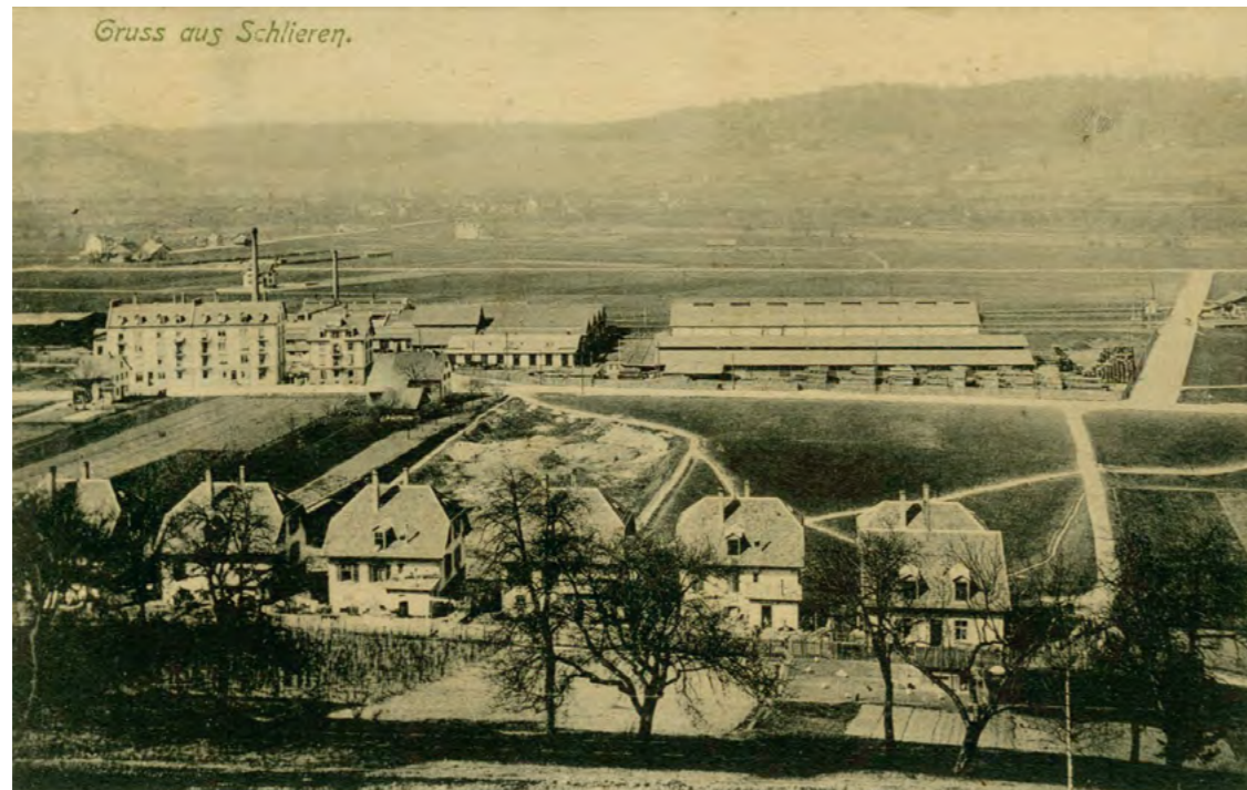
55 ca. 1908 Wagonsfabrik, Schul- und Allmendstrasse, von Süden her
