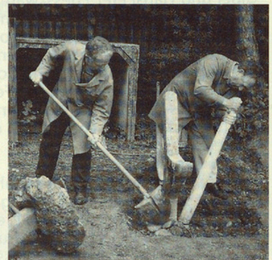
Erde auffüllen und feststampfen
