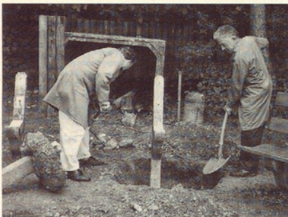
Der zerstörte, einbetonierte Sockel wird mühsam herausgeschaufelt
