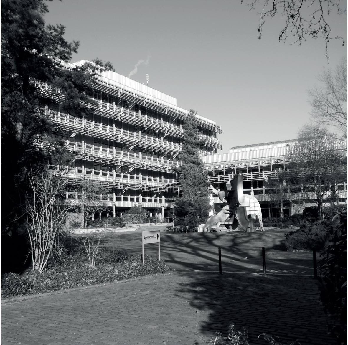
Hauptgebäude der Berufsbildungsschule Winterthur BBW an der Wülflingerstrasse 17 – im Hof der „Grosse Zyklop“ von Bernhard Luginbühl.
