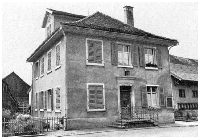
Wangen. Hegnaustrasse. Altes Schulhaus (Vers.Nr. 93), abgebrochen 1970.
