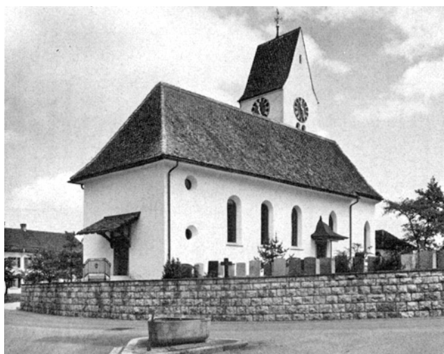
Wildberg. Reformierte Kirche. Nach der Renovation 1971/72.
