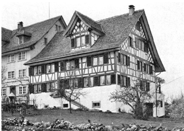
Kilchberg, Dorfstrasse 116. Reihenhaus Vers.Nr. 493. Nach der Renovation 1973/74.
