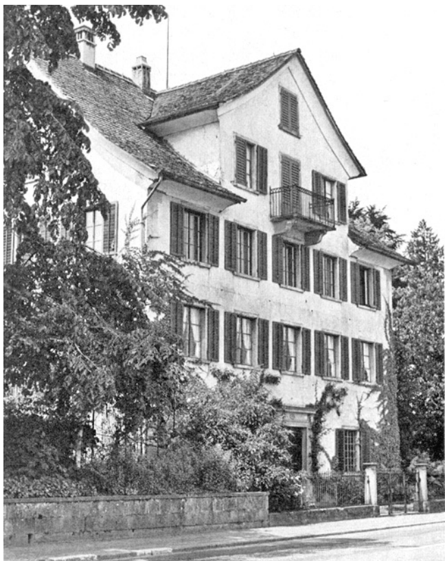
Thalwil. Seestrasse 147. Ehem. Haus Vers.Nr. 670.
