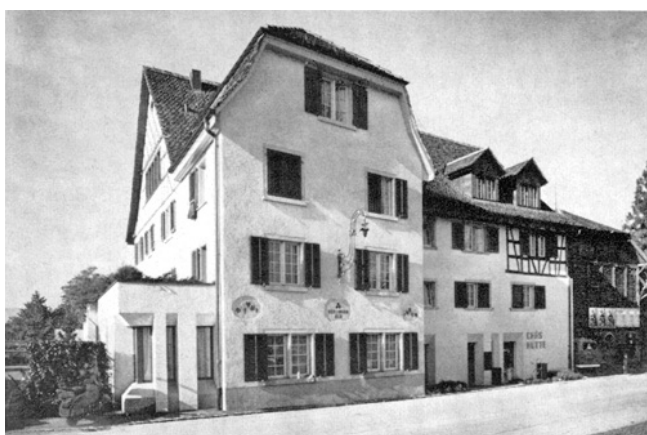
Zollikon. Restaurant «Traube». Nach der Renovation 1975.
