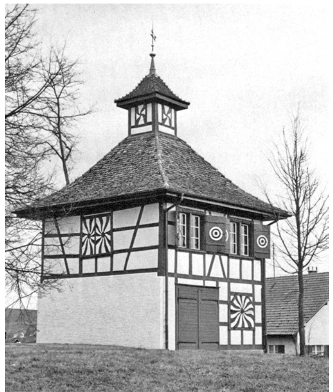
Marthalen. Lindenhof. Ehem. Schützenhaus. Nach der Renovation 1972.
