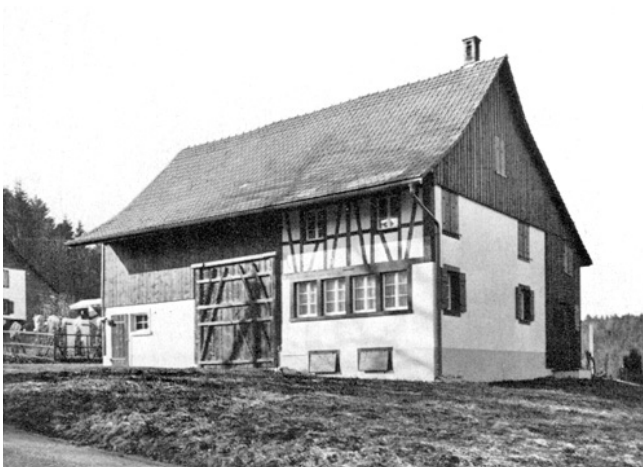
Bauma, Silisegg. Ehem. Bauernhaus Vers. Nr. 298. Oben: vor der Renovation; unten: nach der Renovation 1974.
