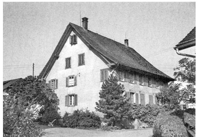
Knonau. Doppel-Bauernwohnhaus Vers. Nr. 461, abgebrochen 1970.
