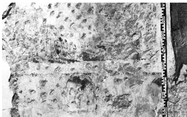
Fehraltorf. Reformierte Kirche. Südwand-Mittelteil. Gotische Wandmalereiestereste.
