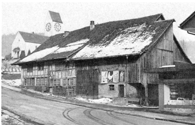
Weiningen. Regensdorferstrasse 4, abgebrochen 1969.
