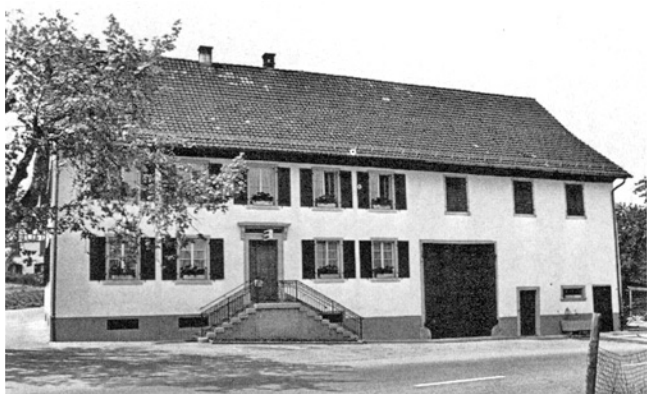
Kleinandelfingen, Örlingen. Restaurant «Zur Traube». Nach der Renovation 1973.
