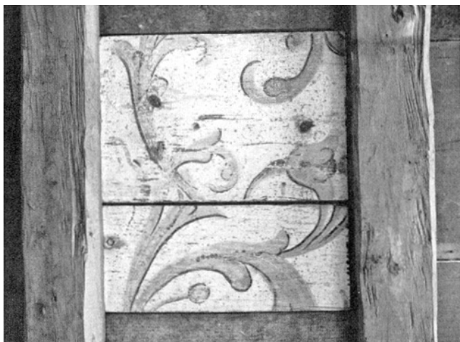
Winterthur. Altstadt. Obertor 33. Reste einer bemalten Balkendecke.
