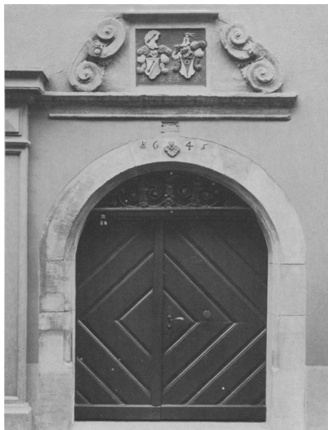
Eglisau, Untergass. Haus Vers. Nr. 591/593. Portal. Nach der Restaurierung 1974.
