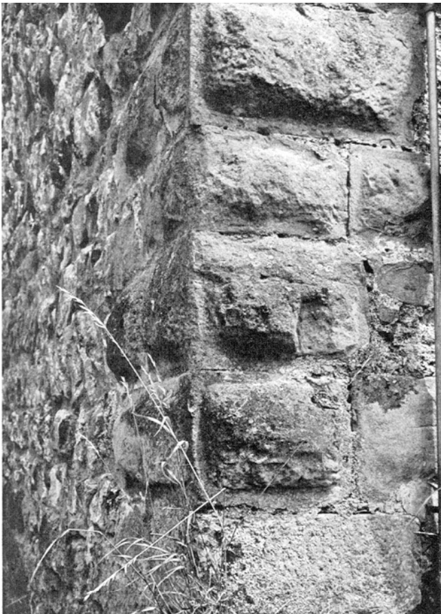
Greifensee. Sog. Schloss-Scheune (ehem. romanischer Palas). Südwestmauer vor der Renovation 1969/1970. Bossenquader an der Westecke.
