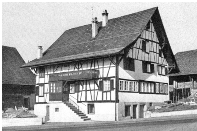
Ottenbach. Muristrasse. Bauernwohnhaus Vers.Nr. 247–249. Nach der Renovation 1972.
