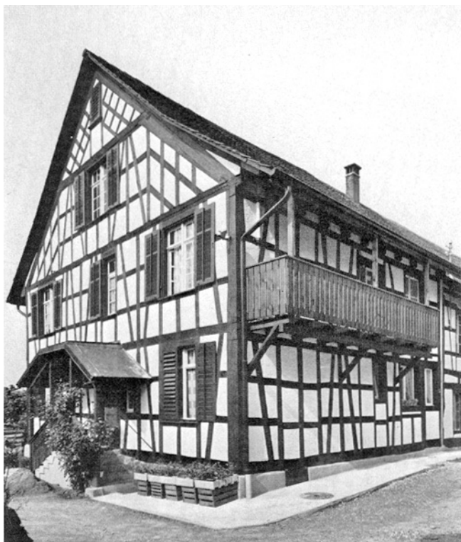
Trüllikon. Rudolfingen. Wohnhaus Vers.Nr. 276. Nach der Renovation 1973.
