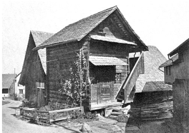
Oberrieden. Länzweg. Speicher Vers.Nr. 622. Vor der Renovation 1973.
