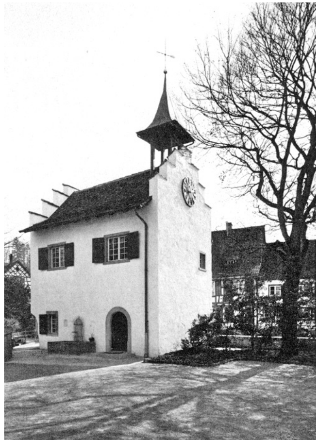
Andelfingen. Schloss. Ehem. Pförtnerhaus. Nach der Restaurierung 1971.
