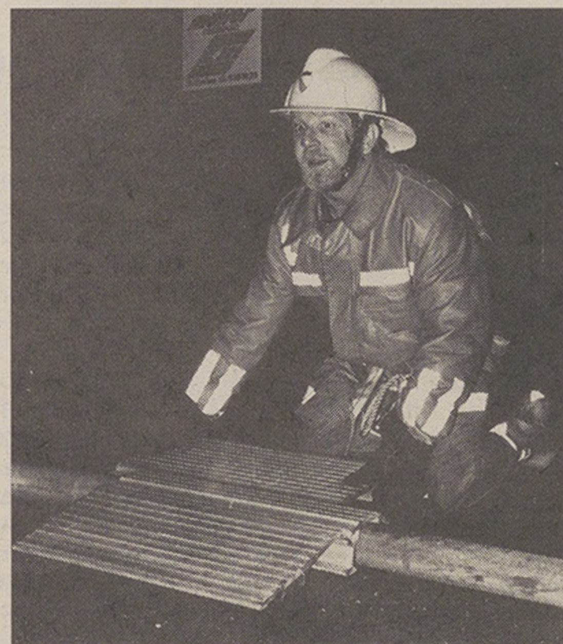
Beck Baur schiebt kein Backblech in den Ofen... aber die Schwelle für den wartenden VBZ-Bus will auf Radspur ausgerichtet sein.
