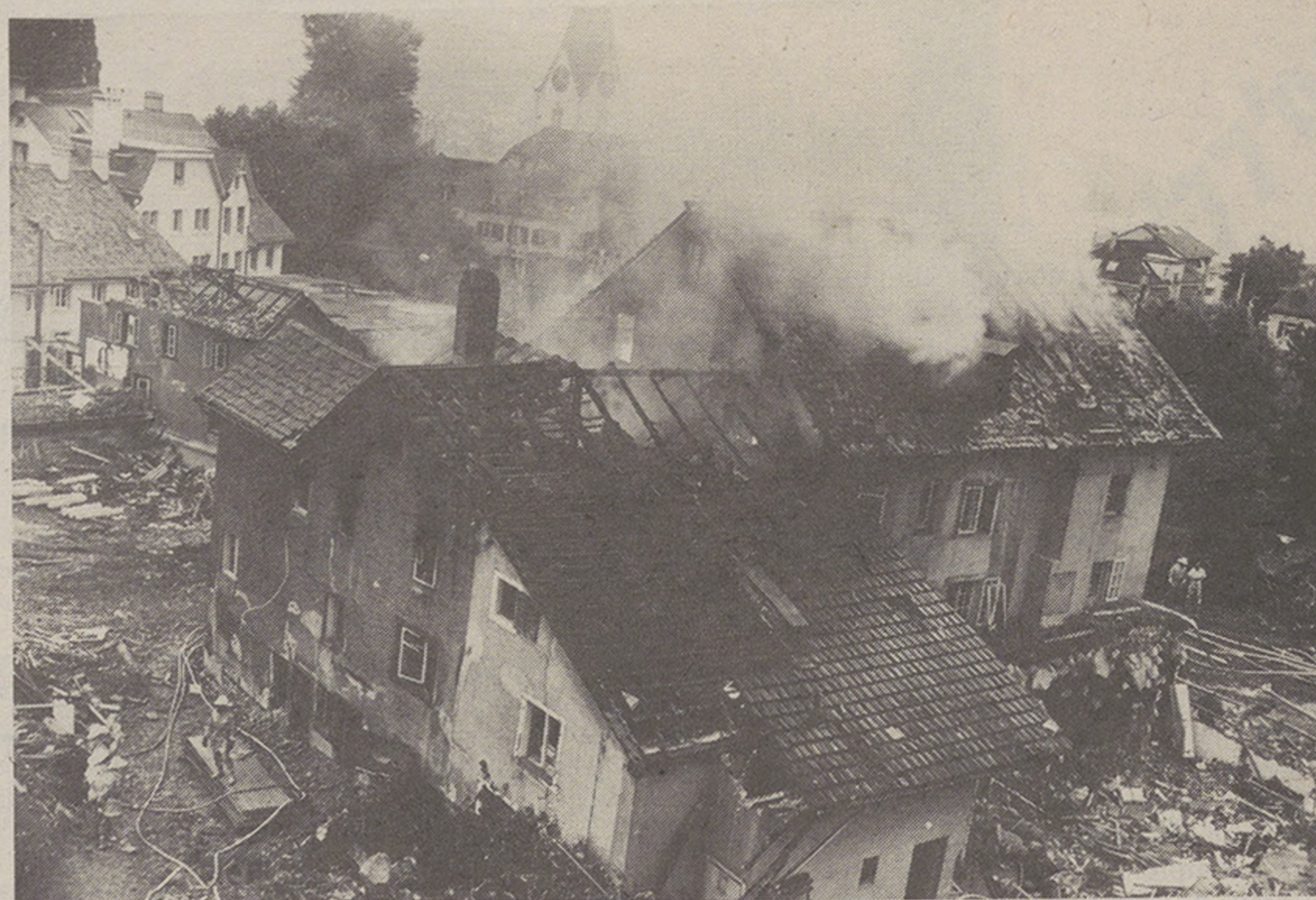
Die vier Abbruchhäuser an der Regensdorferstrasse 190 bis 194 waren Mittelpunkt der Feuerwehrrübung vom Dienstagabend.
