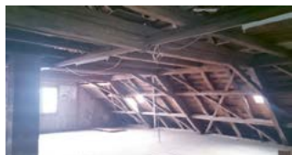
Bestehender Dachstuhl (Original)
