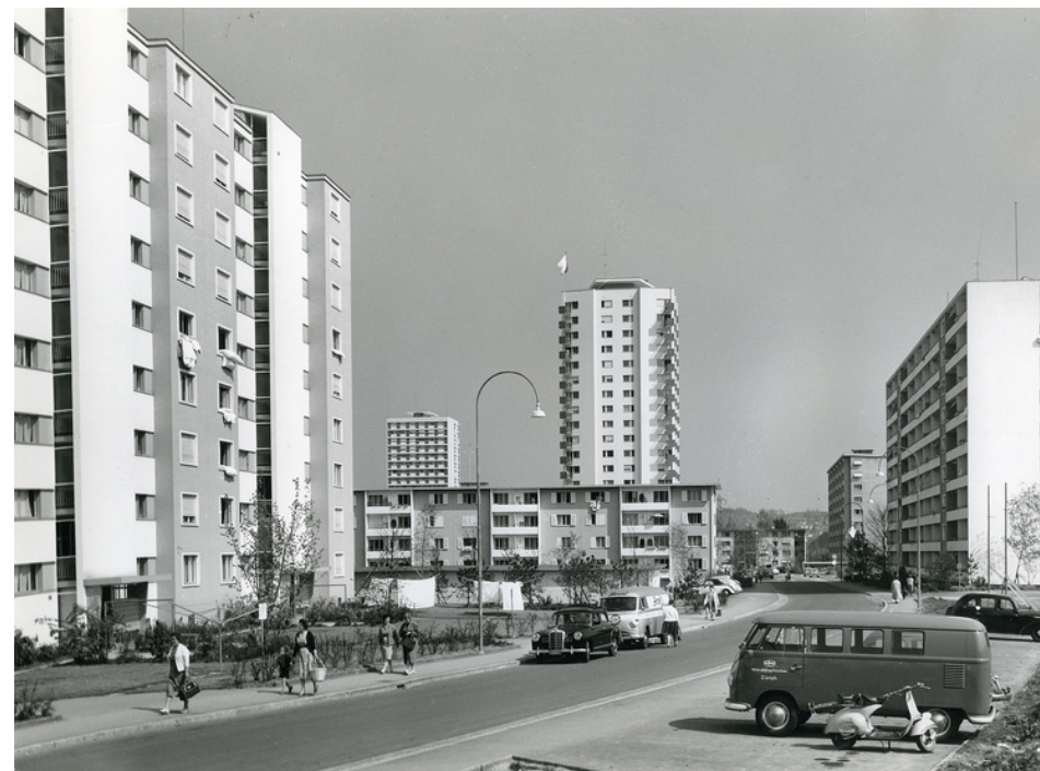
Neubauquartier der 1950er-Jahre an der Hirzenbachstrasse (Bild: BAZ_133293, Carl Hässler)
